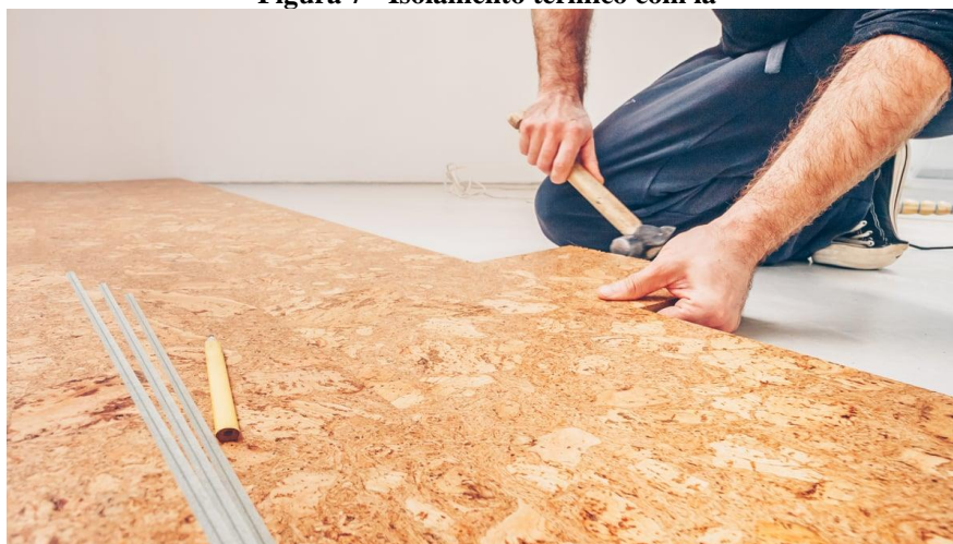
Figura 7 - Isolamento térmico com lã
