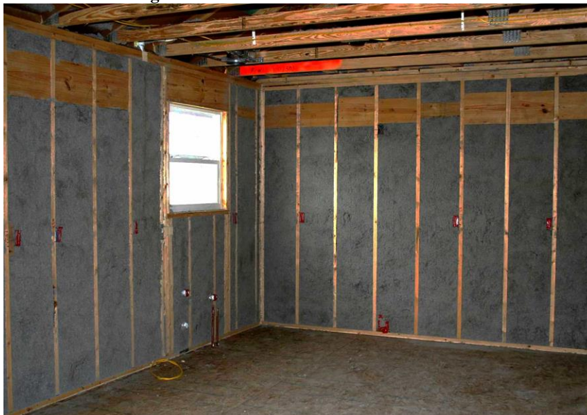
Figura 8 - Isolamento térmico com Celulose
