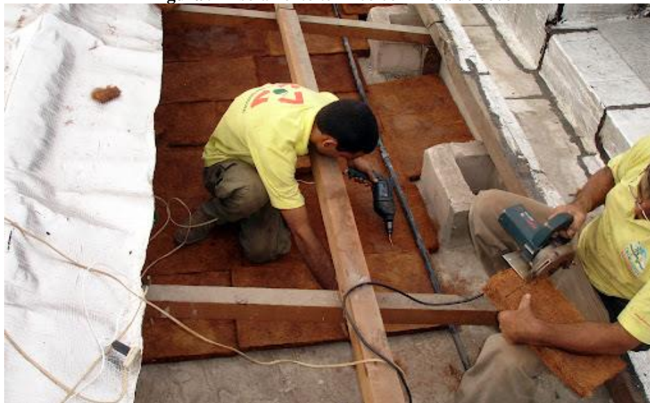
Figura 9 - Isolamento térmico com fibra de coco
