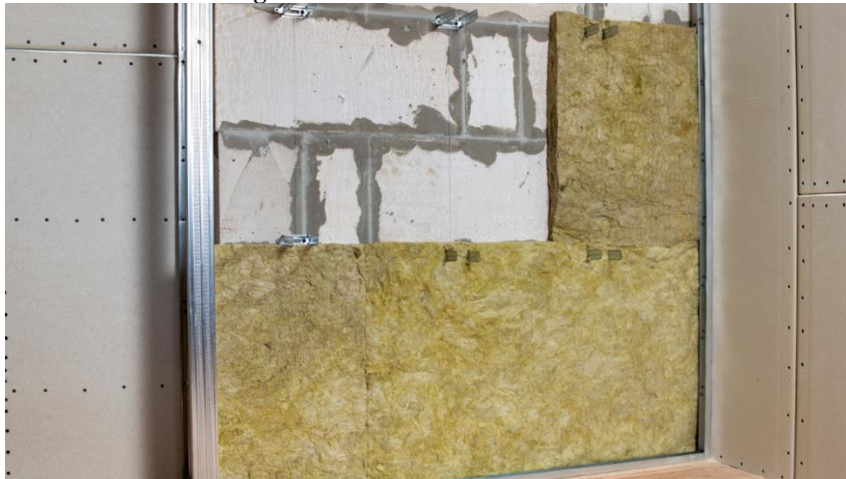
Figura 6 - Isolamento térmico com lã
