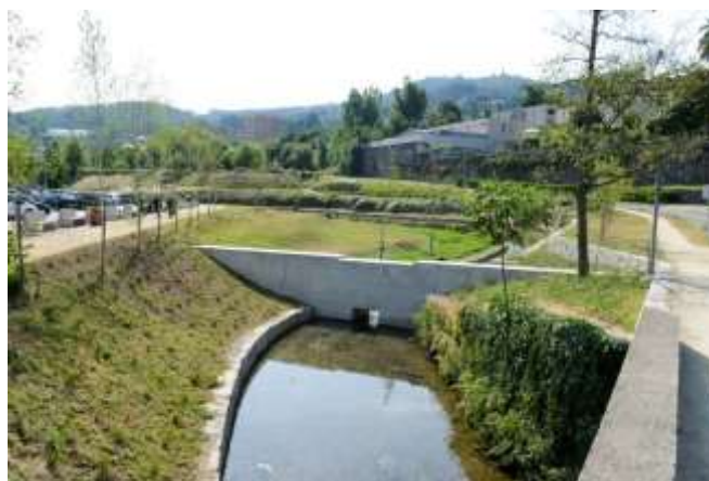
Figura 7 - Exemplo de bacia de retenção
