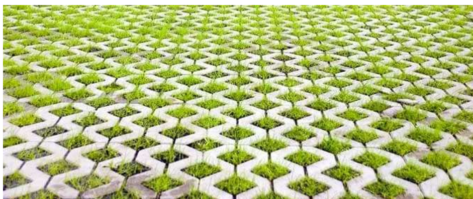
Figura 10 - Exemplo de pavimentos permeáveis
