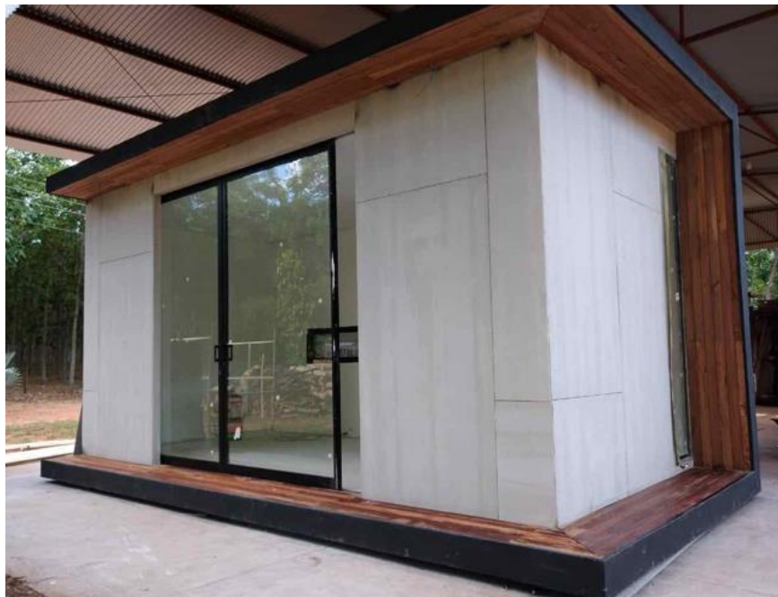
Figura 5.1: Protótipo modular construído
