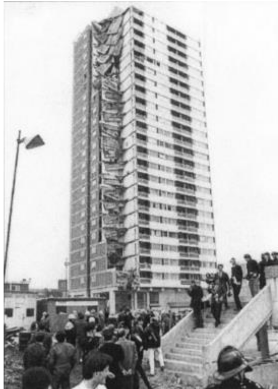
Figura 2.4: Edifício Ronan Point após colapso (PEARSON, 2005)
