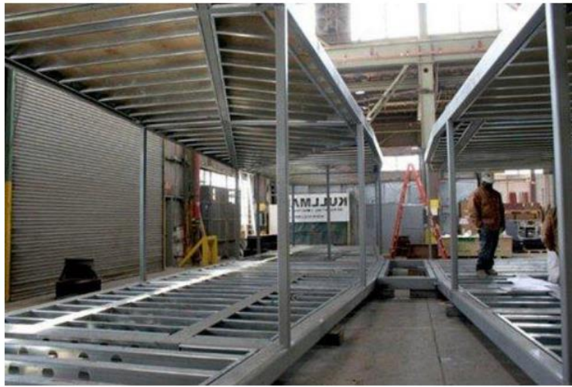
Figura 3.2a: Montagem típica de estrutura de aço em fábrica (VELAMATI, 2012)
