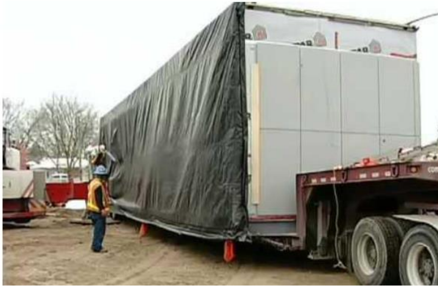
Figura 3.4: Início do transporte de uma unidade modular (DOERMANN, 2020)
