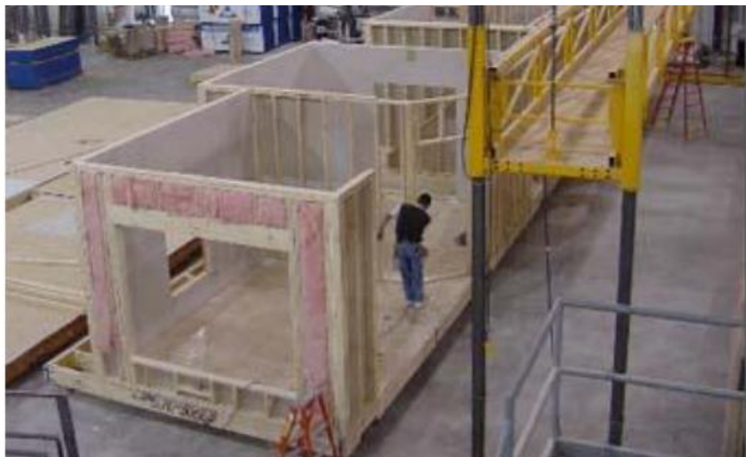
Figura 3.2b: Montagem típica de estrutura de madeira maciça em fábrica (VELAMATI, 2012)
