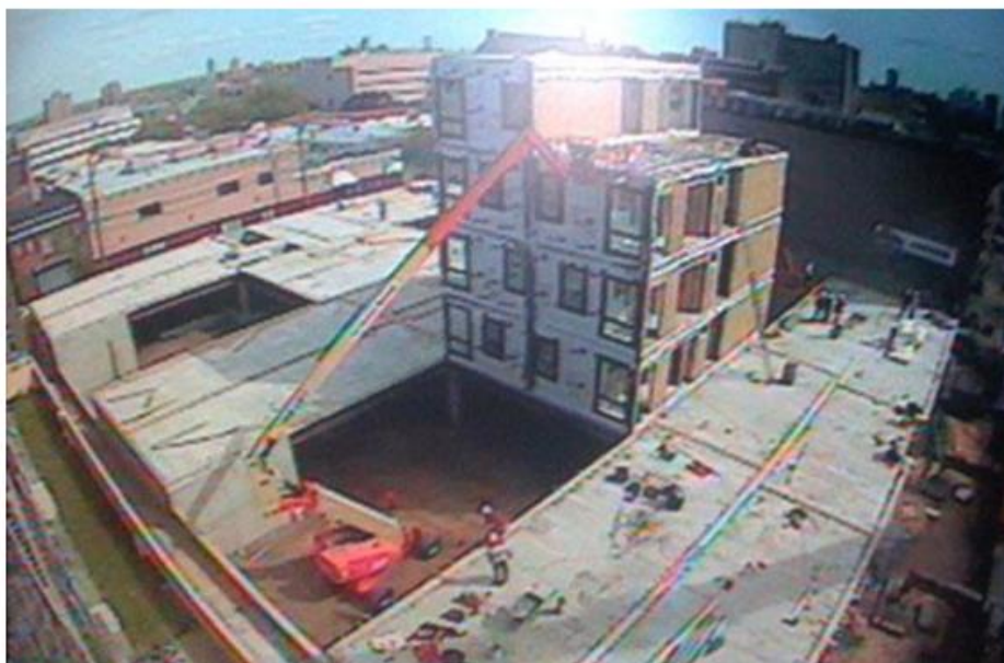
Figura 3.5: Instalação das unidades e montagem do edifício (VELAMATI, 2012)
