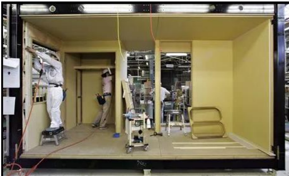
Figura 3.3: Trabalhadores da Toyota em montagem unidade modular (ARCHNET, 2019)
