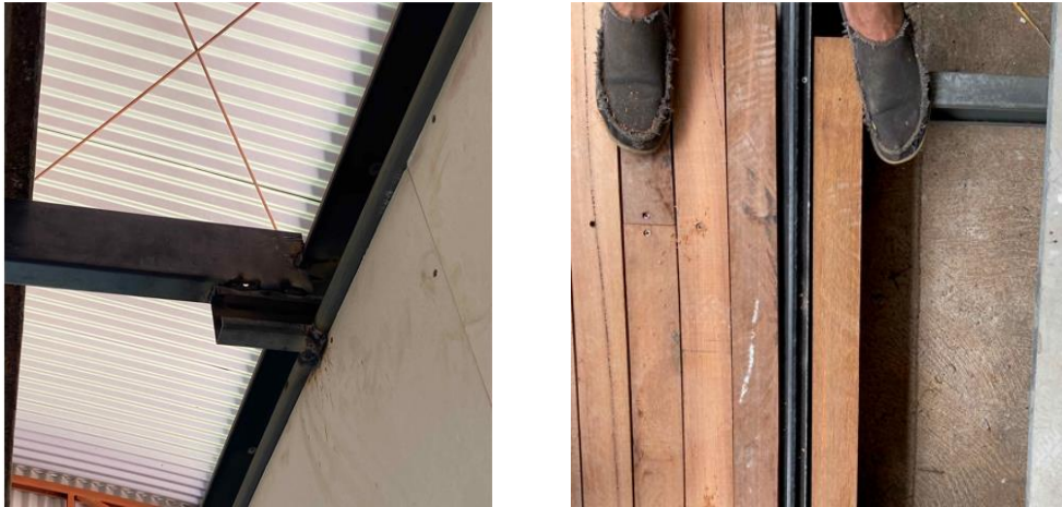
Figura 5.4a 5.4b: Cobertura e estrutura do piso.
