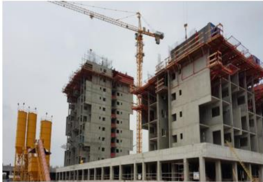
Figura 2.1: Construção usando Tunnel Formwork (APTE, 2016)
