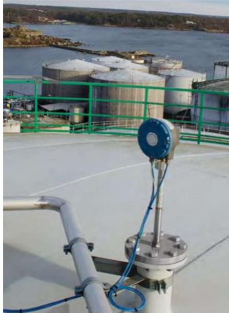
**Figura 7: Transmissor de temperatura**
