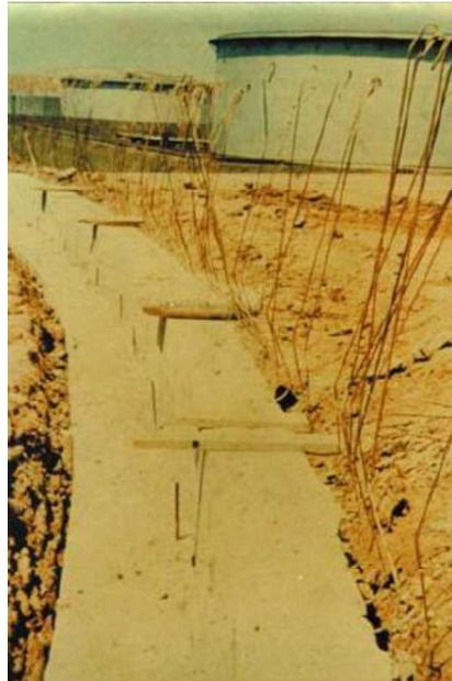
**Figura 5: Fundação com anel de concreto**
