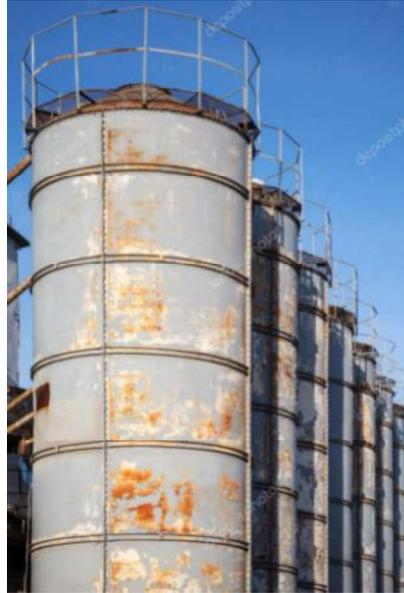
**Figura 43: Tanque de armazenamento com corrosão aparente no costado**
