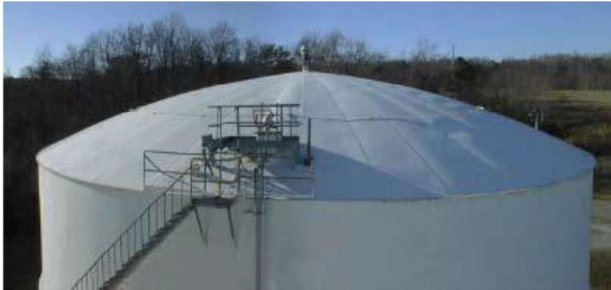
**Figura 12: Tanque com teto fixo em gomos**
