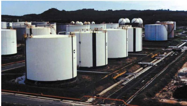
Figura 10: Tanque com teto fixo cônico
