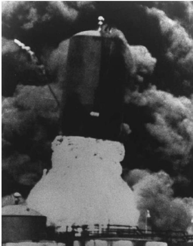
**Figura 23: Ruptura da junta entre o fundo e costado**
