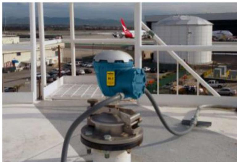
**Figura 6: Medidor de nível tipo radar**
