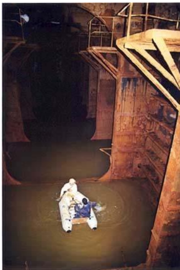
Figura 4.3 - Vistoriador realizando inspeção de um tanque de navio petroleiro
