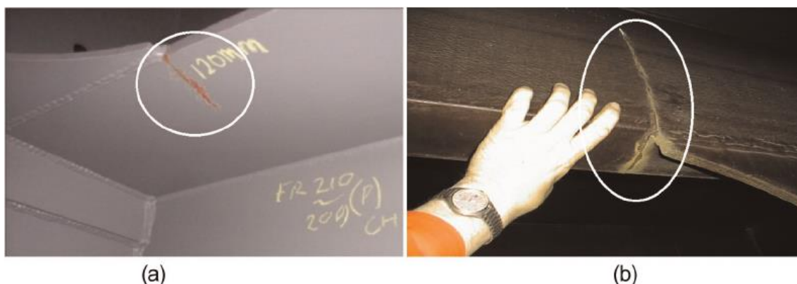
Figura 4.2 - Trincas encontradas em reforçadores de estruturas navais
