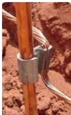
Figura 2.10 - Conector cunha em liga de cobre tipo conexão a compressão.
