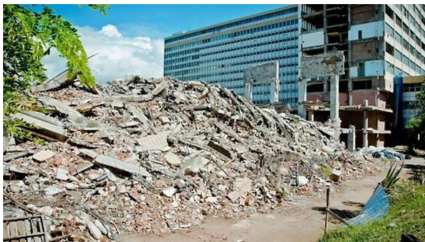
Figura 7 - Resíduos oriundos da implosão do Hospital Universitário Clementino Fraga Filho da Universidade Federal do Rio de Janeiro (HUCFF/UFRJ)
