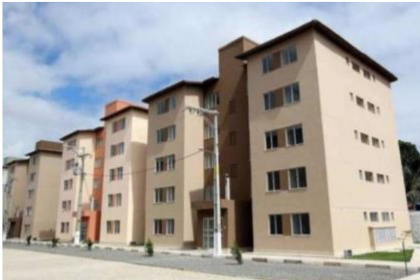
Figura 16 - Unidades habitacionais verticais MCMV Fonte: (Caixa Econômica Federal, 2017).
