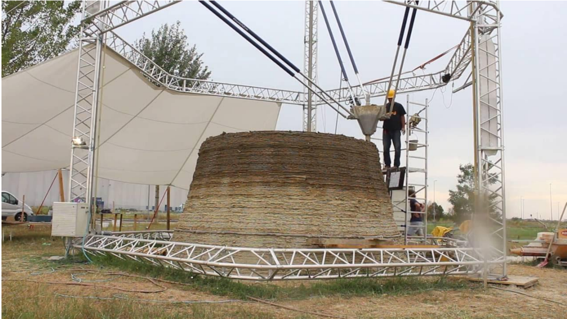
Figura 23- Etapa produção de casa utilizando a Bigdelta. Fonte: (3dwasp, 2012).
