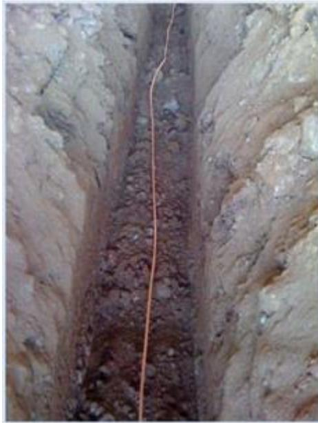
Figura 3.10:Fio condutor estendido em uma vala - Fonte: Energisul [20]
