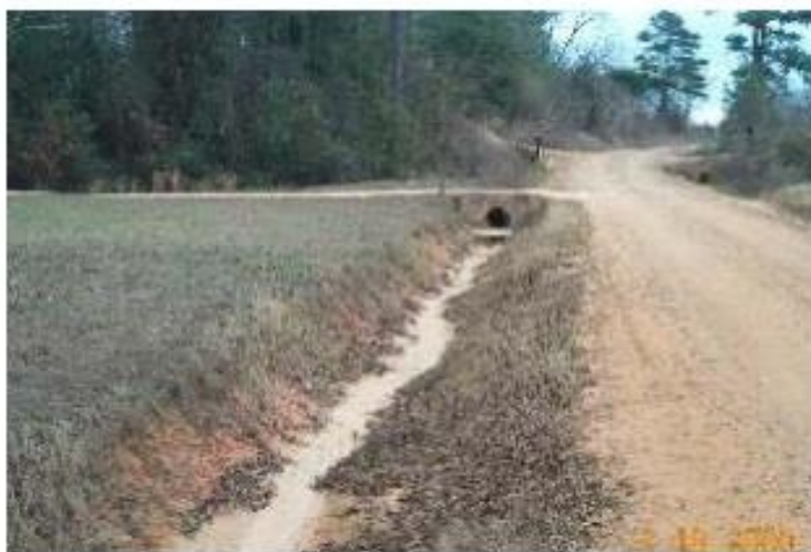
Figura 2 – Exemplo de uma sarjeta corretamente executada (FATTORI, 2007).
