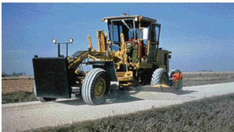
Figura 3 – Motoniveladora espalhando o solo pela pista (SKORSETH e SELIM, 2000).
