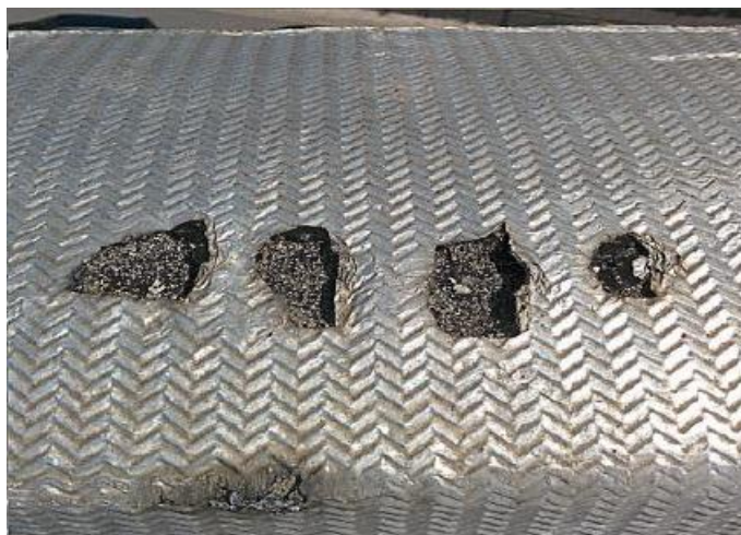
Figura 76 - Perfuração de manta. Fonte: POÇA (2015)
