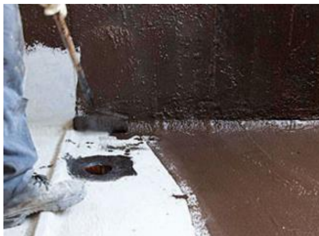
Figura 12 - Membrana rígida. Fonte: FERREIRA (2012)
