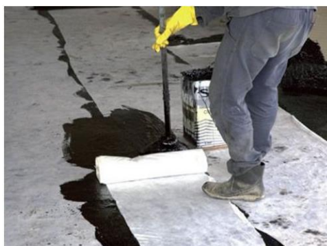
Figura 15 - Aplicação do véu de poliéster. Fonte: BUSIAN (2013)
