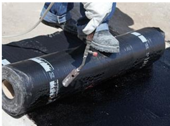
Figura 11 - Manta flexível. Fonte: FERREIRA (2012)
