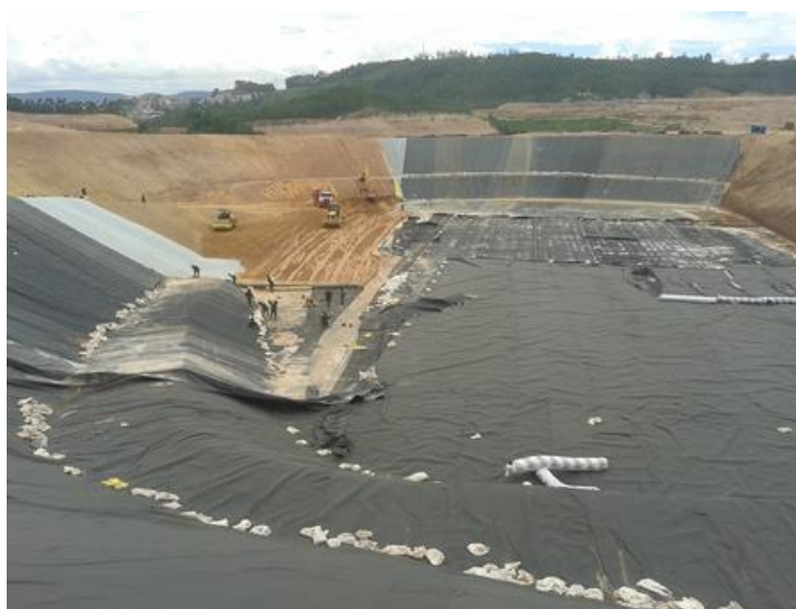
Figura 1 - Aplicação de impermeabilizante geossintético. Fonte: PEDRONI (2015)
