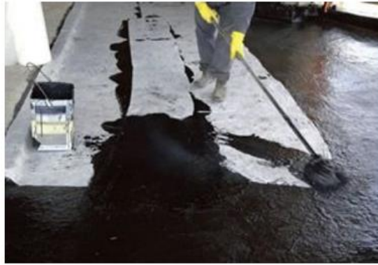
Figura 16 - Aplicação de demão sobre o estruturante. Fonte: BUSIAN (2013)
