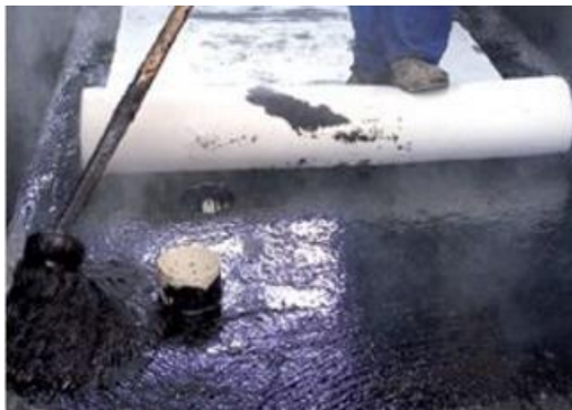
Figura 18 - Membrana asfáltica aplicada a quente. Fonte: FERREIRA (2012)
