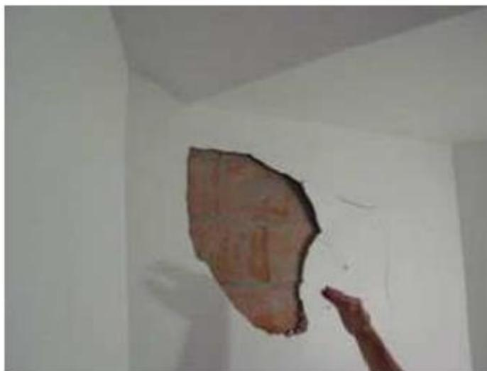
Figura 41: Descolamento da argamassa de revestimento. Fonte: ABCP, 2006.
