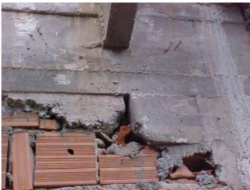
Figura 22: Elementos em concreto armado com irregularidades geométricas. Fonte: Brandão, 2007.
