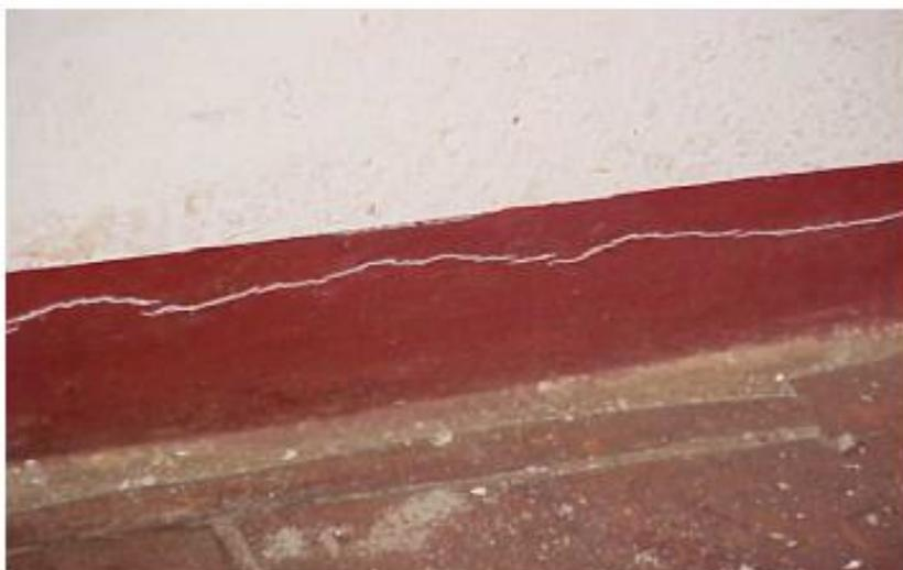
Figura 28: Trinca horizontal na base da alvenaria por efeito da umidade do solo. Fonte: Brandão, 2007.
