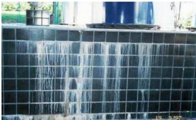
Figura 46: Manchas em revestimento cerâmico devido à eflorescência. Fonte: ABCP, 2006.
