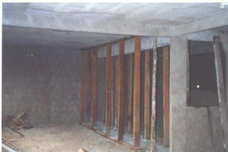
Figura 16: Estrutura em concreto armado escorada devido a deformação estrutural. Fonte: Brandão, 2007.
