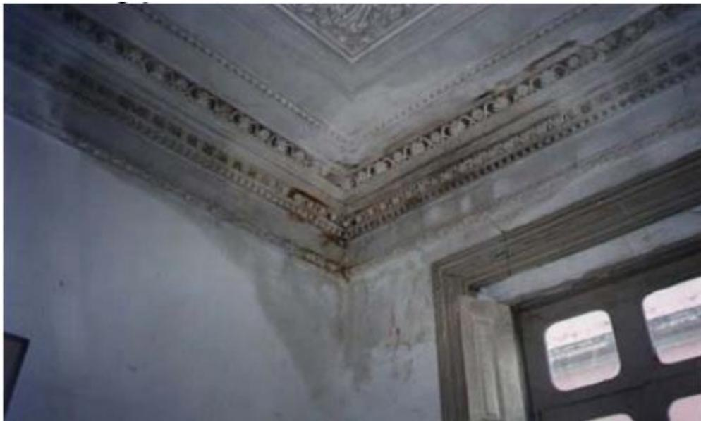
Figura 49: Forro em gesso com presença de umidade. Fonte: Peres, 2001.
