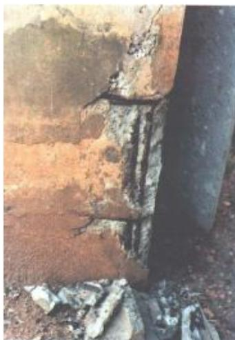
Figura 17: Corrosão da armadura em pilar. Fonte: Cascudo, 1997.
