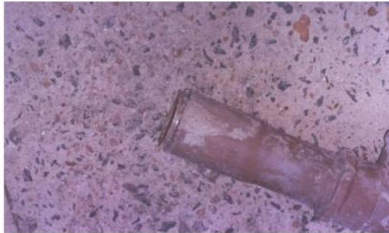
Figura 34: Trechos de tubulações unidas a fogo sem utilização de conexões. Fonte: Brandão, 2007.
