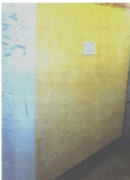
Figura 45: Fissuras mapeadas devido à retração da argamassa. Fonte: Angelim, 2000.
