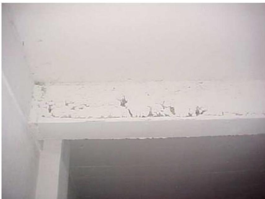
Figura 23: Concreto armado com segregação. Fonte: Brandão, 2007.
