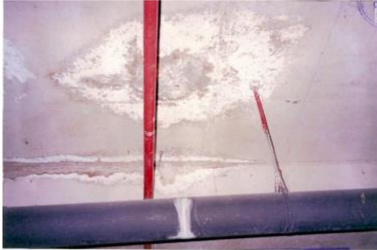
Figura 19: Laje térrea com eflorescência devido ao processo de lixiviação. Fonte: Brandão, 2007.
