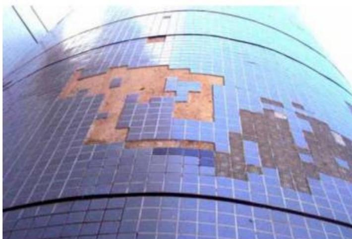
Figura 48: Destacamento do revestimento cerâmico em fachada. Fonte: Comunidade da Construção, 2004.
