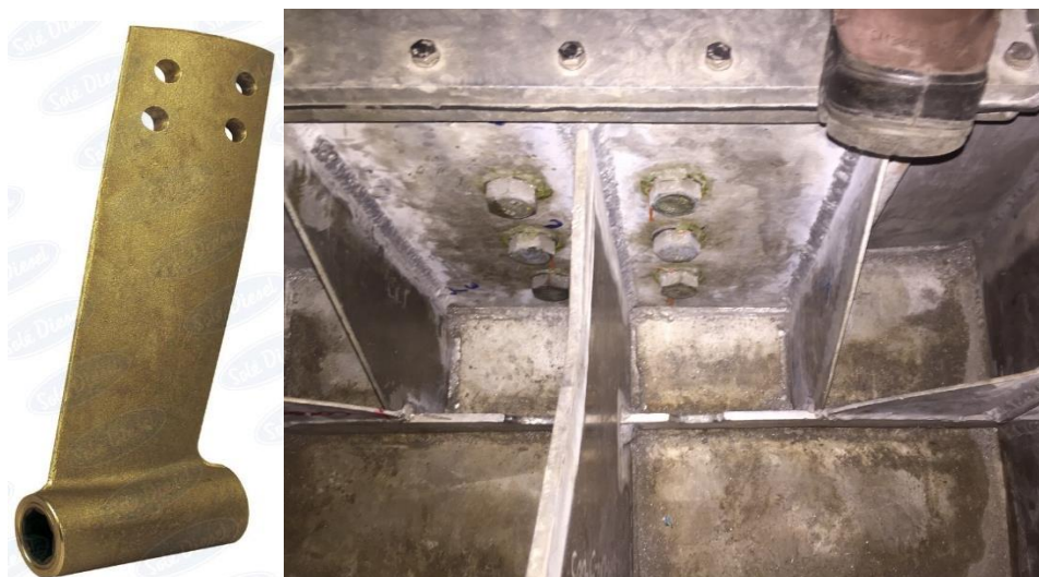
Figura 27 – Demonstração dos furos e parafusos de fixação na caixa.
