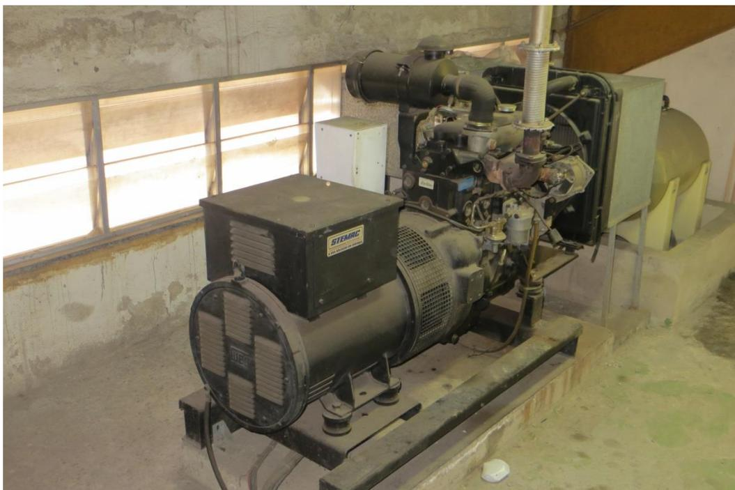
**Figura 35: Grupo motor-gerador de 44kVA instalado no estádio**
