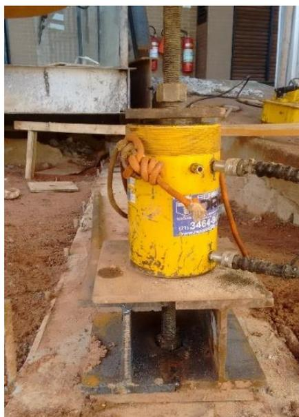
Figura 6-9: Posicionamento de macaco hidráulico em tirante
