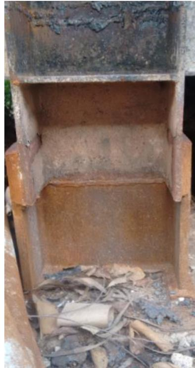
Figura 6-10: Prolongamento dos pilares metálicos (a) detalhes das fases (b) pilar com prolongamento finalizado
