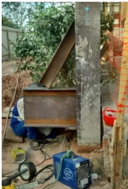
Figura 6-2: Estrutura para renivelamento de pilar metálico
