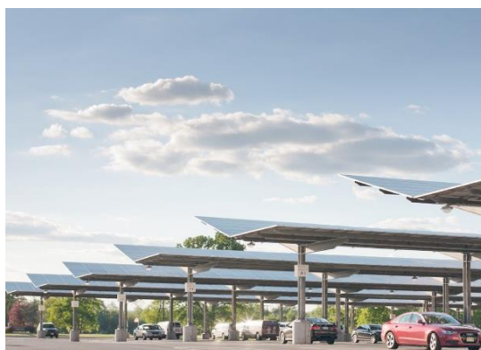
Figura 7 - Cobertura de estacionamento utilizando módulos fotovoltaicos, Rutgers University, 8MWp, New Jersey, Estados Unidos, 2013 [10]
