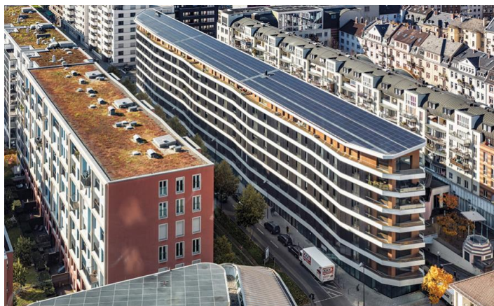
Figura 8 - Prédio com sistema solar integrado na cobertura, Gutleutviertel, Frankfurt, Alemanha, 2015 [11]
