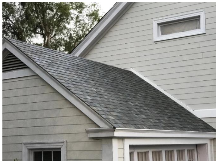
Figura 9 - Telha composta por células fotovoltaicas, Estados Unidos, 2016 [12]
