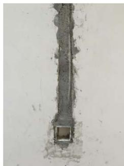
Figura 35 - Falta de integração com as instalações. Fonte: WU et al. (2016)
