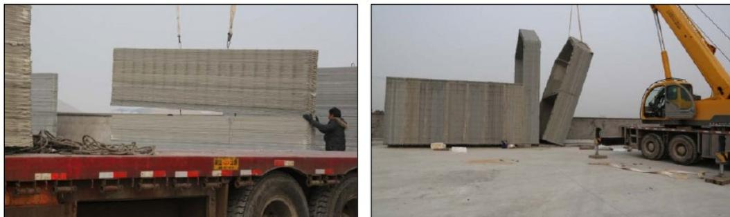
Figura 32 - Içamento das partes impressas. Fonte: CHARRON (2015)
