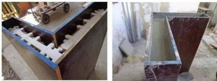
Figura 12 - Sistema de Alvenaria Moldada antes e depois da concretagem. Fonte: SHC (2013)
