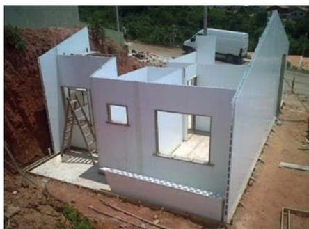
Figura 13 - Casa em Concreto PVC. Fonte: GLOBAL HOUSING (2013)
