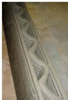
Figura 15 - Parede impressa. Fonte: CONTOUR CRAFTING (2016)
