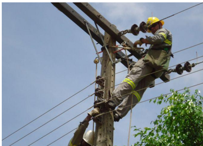
Figura 3.23: Manutenção na rede de distribuição [32]
