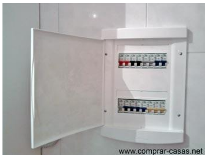
Figura 3.16: Identificação dos circuitos [16]
