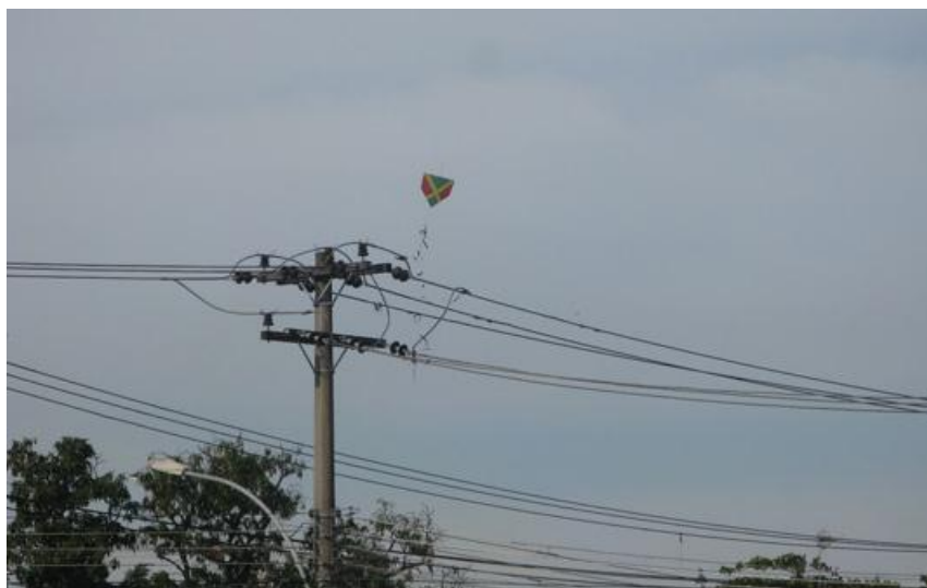
Figura 3.29: Pipa próximo a rede elétrica [36]
