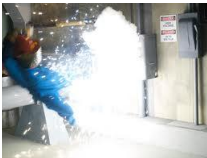
Figura 2.12: Arco elétrico em serviço de manutenção [12]
