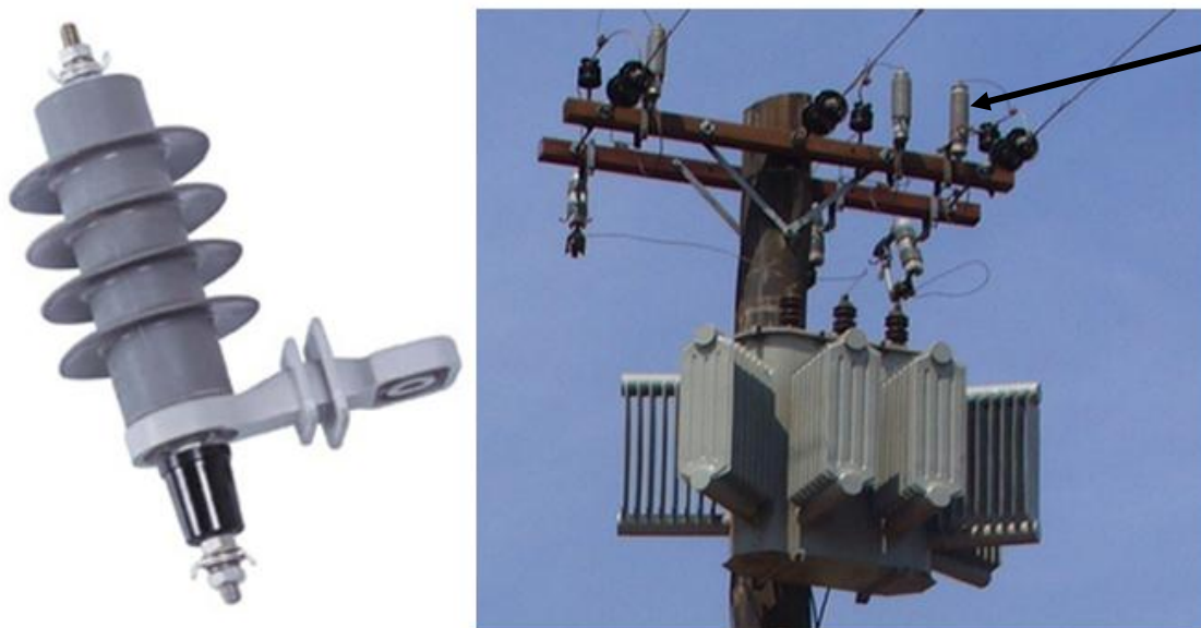
Figura 3.30: Para-raios em linhas de distribuição [22]
