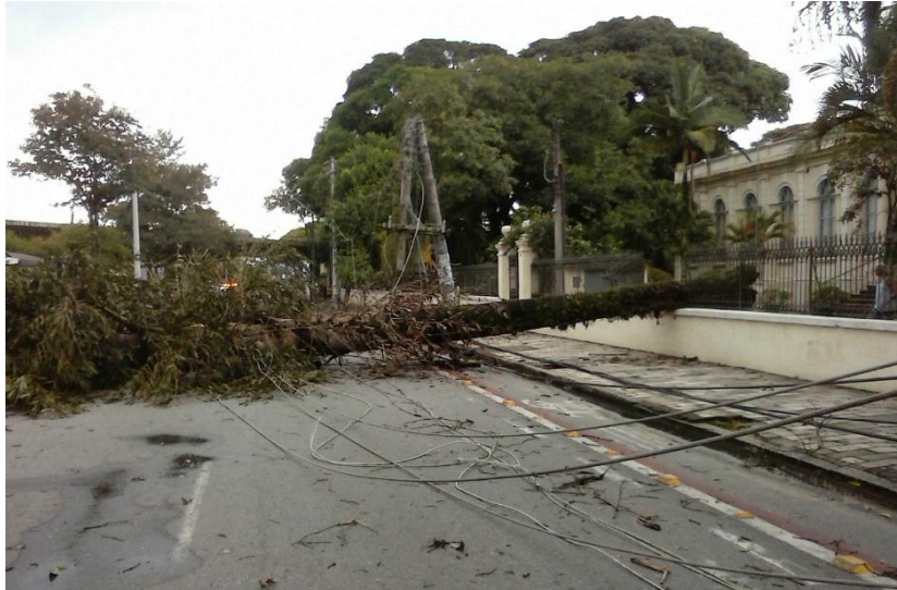
Figura 3.20: Queda de árvore na rede elétrica [29]
