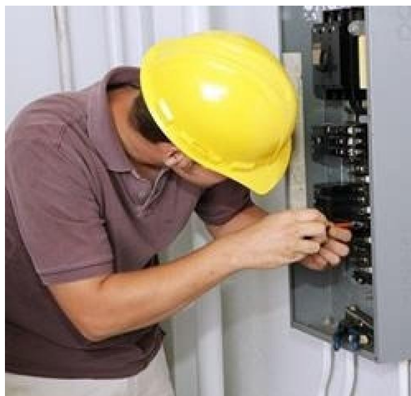
Figura 3.18: Troca de disjuntores em um quadro de distribuição [27]
