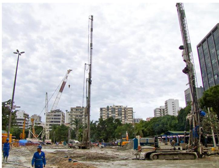
Figura 26 - Execução de *Jet Grouting* na estação Nossa Senhora da Paz
