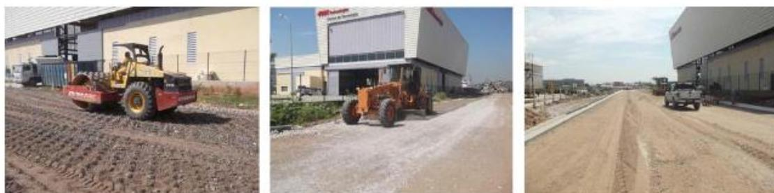
**Figura 22 - Execução da base realizada em RCD**
