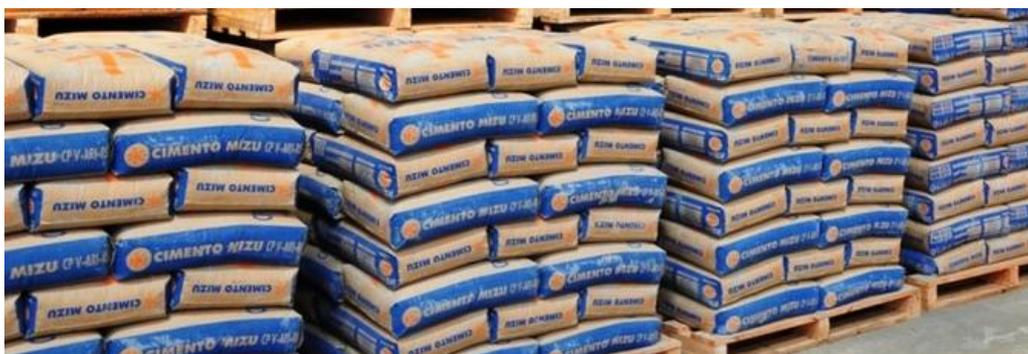
Figura 6 - Armazenamento de cimento em canteiro de obra
