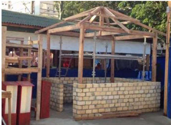
**Figura 31 - Tijolos utilizados na guarita em construção**
