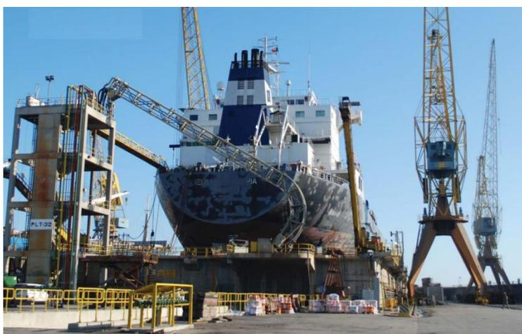
Figura 4.10 - Detalhe de um dique do Hydrolift, situado acima do nível do solo
