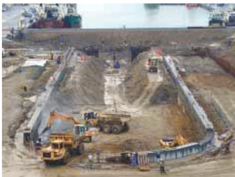
Figura 4.2 - Construção de um dique seco
