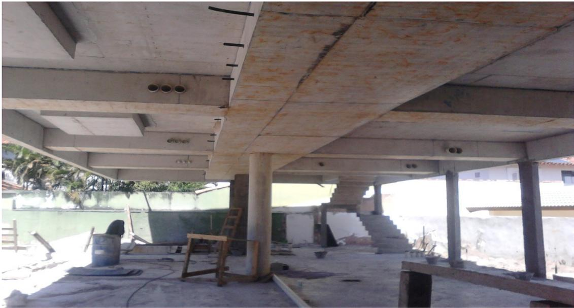
Figura 8: Posição de furos nas vigas para passagem de instalações;
