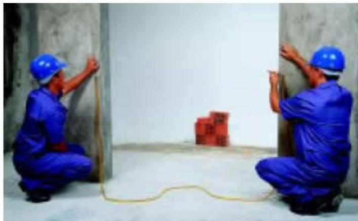
Figura 22: Determinação do nível através de mangueira de borracha
