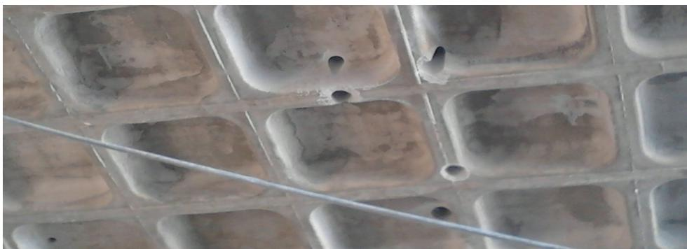
Figura 4: Incompatibilização do projeto de estrutura com projeto hidráulico.
