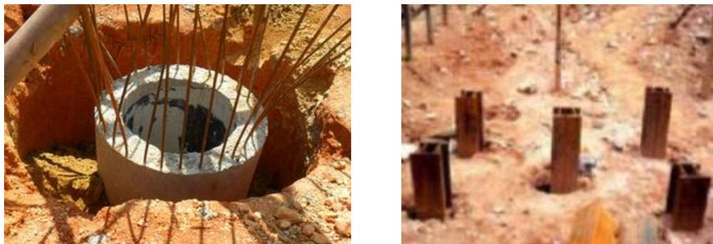
**Figura 16: Tubulão e Estacas metálicas**
