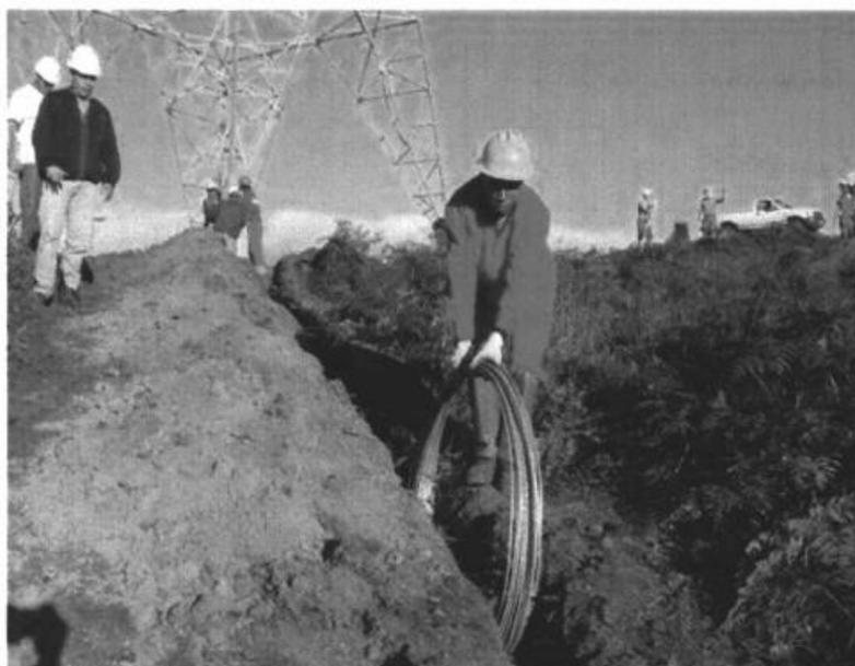
**Figura 18: Instalação de cabo contrapeso para aterramento**
