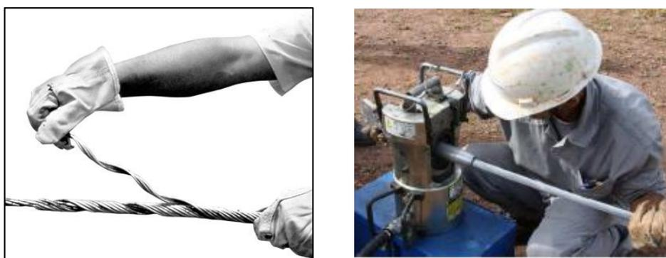
**Figura 28: Emenda preformada e emenda à compressão**
