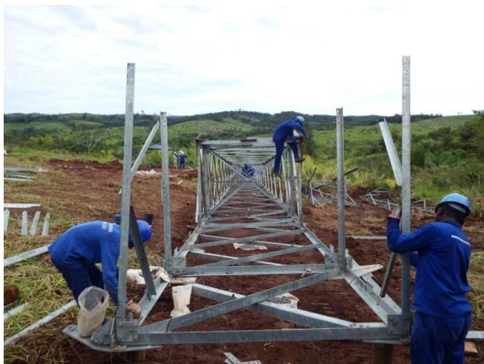
**Figura 22: Pré-montagem de estrutura metálica treliçada**
