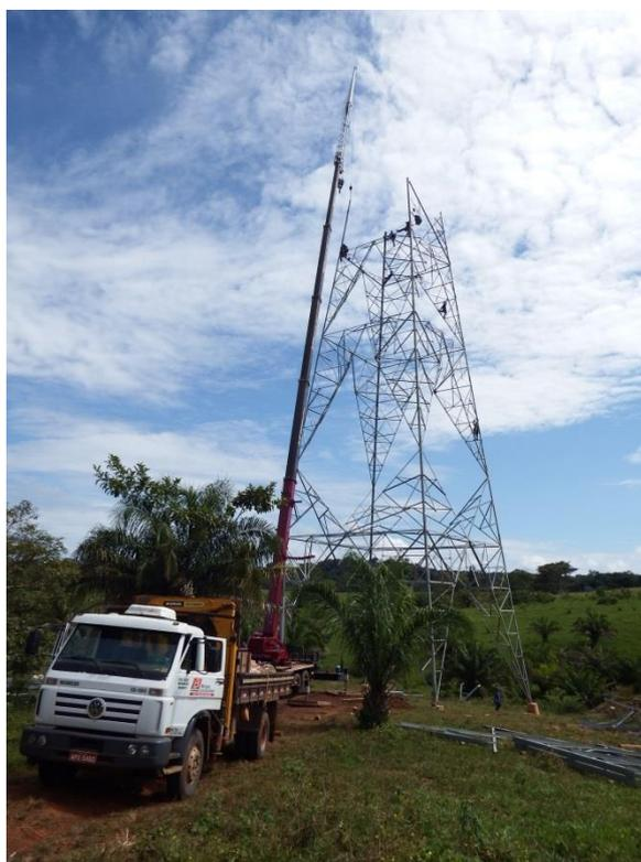
**Figura 23: Montagem mista de estrutura metálica treliçada**
