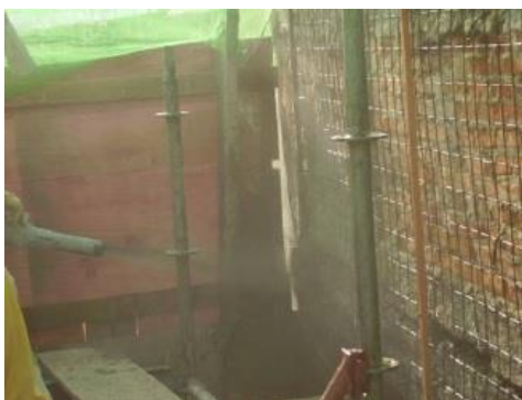
Figura 61 - Execução da projeção de concreto. Fonte: AGUIAR (2011)
