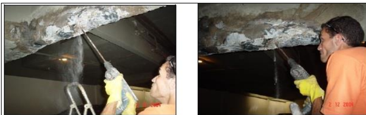
Figura 82 - Processo de furação para colocação dos tubos de injeção. Fonte: ZAPLA (2006)
