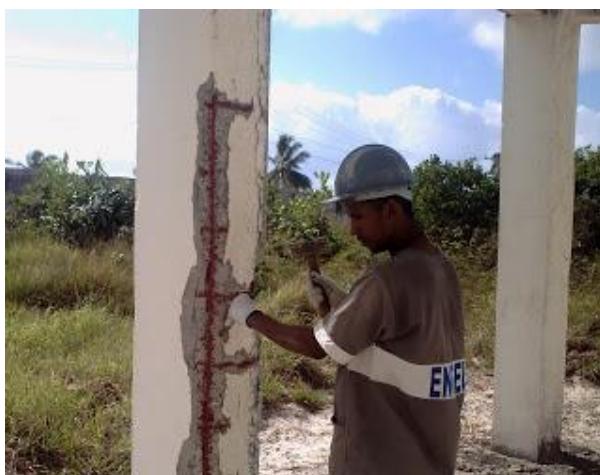
Figura 53 - Apicoamento manual da superfície de concreto. Fonte: SERCPINT (2011)
