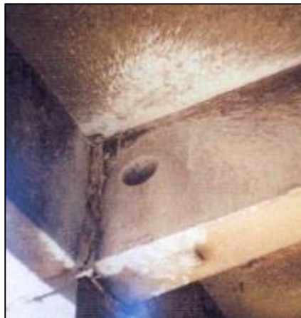
Figura 95 - Extração de corpo-de-prova de uma viga. Fonte: MALHEIROS (2007)
