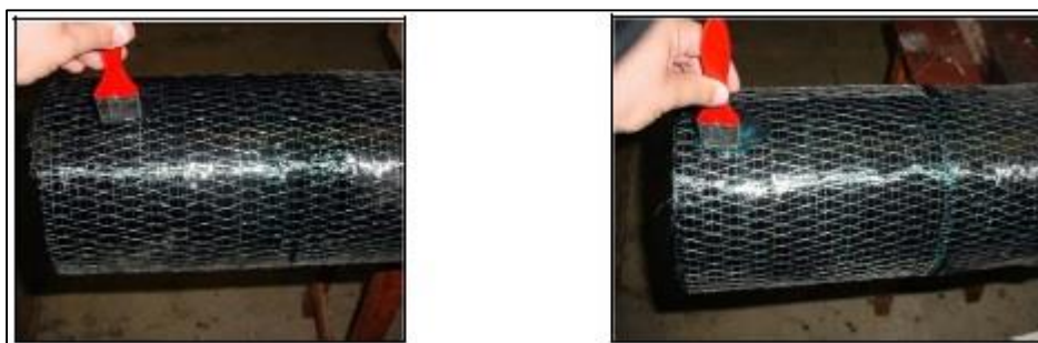
Figura 77 - Aplicação da manta e da resina de colagem (esq.) e por final aplicação de resina saturante (dir.). Fonte: RIGAZZO (2003)
