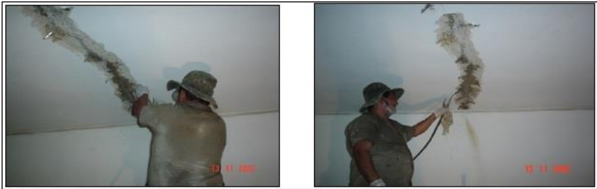
Figura 83 - Processo de injeção de fissuras. Fonte: ZAPLA (2006)
