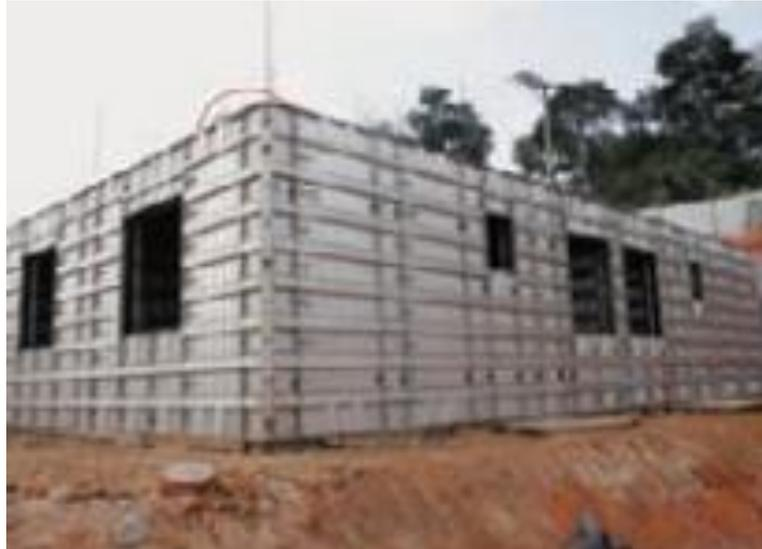
Figura 38 - Exemplo de fôrma metálica utilizada para concretagem de paredes de concreto.
