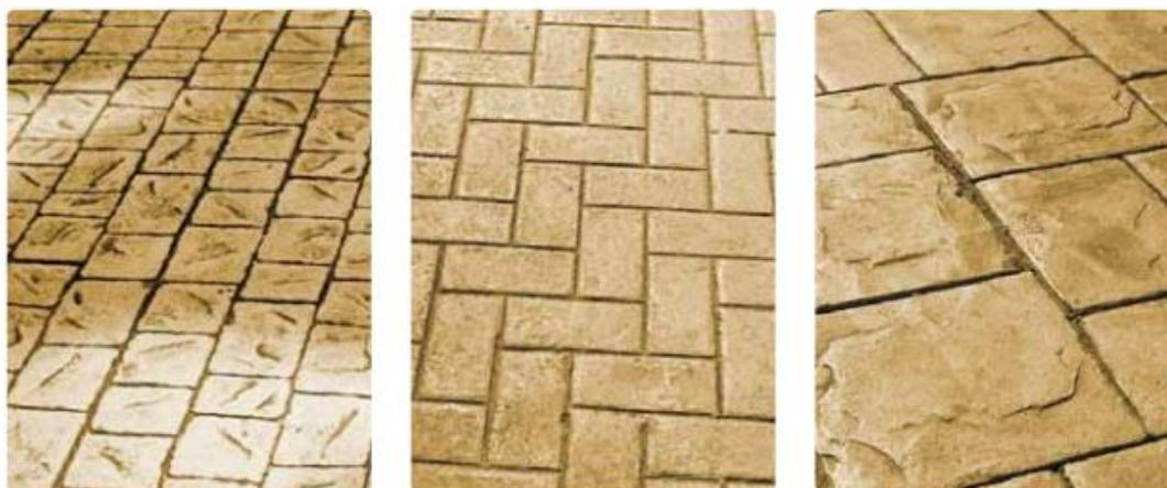
Figura 22 - Concreto estampado representando pedras, peças de concreto e cerâmicas.
