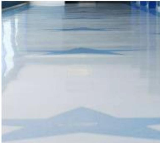
Figura 7 - Piso em concreto colorido moldado *in loco*.
