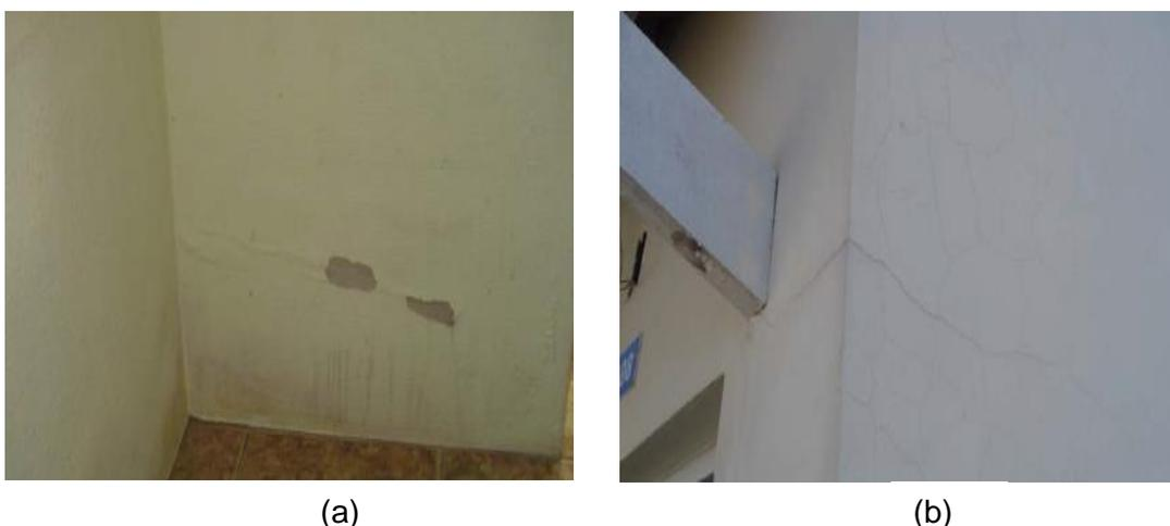
Figura 41 - (a) Desplacamento de pintura e esfarelamento de reboco; (b) Fissuração do revestimento externo.
