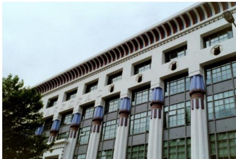
Figura 1 - Edifício da fábrica de cigarros “The Carreras Black Cat”, construído em 1926-28 e primeiro edifício a empregar concreto colorido no mundo.
