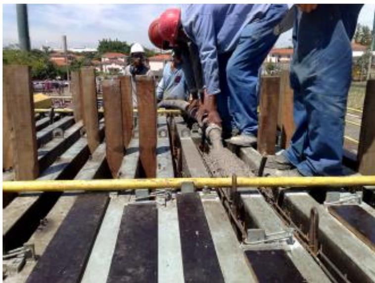
Figura 35 - Etapa de concretagem das fôrmas das paredes de concreto utilizando-se o concreto autoadensável.
