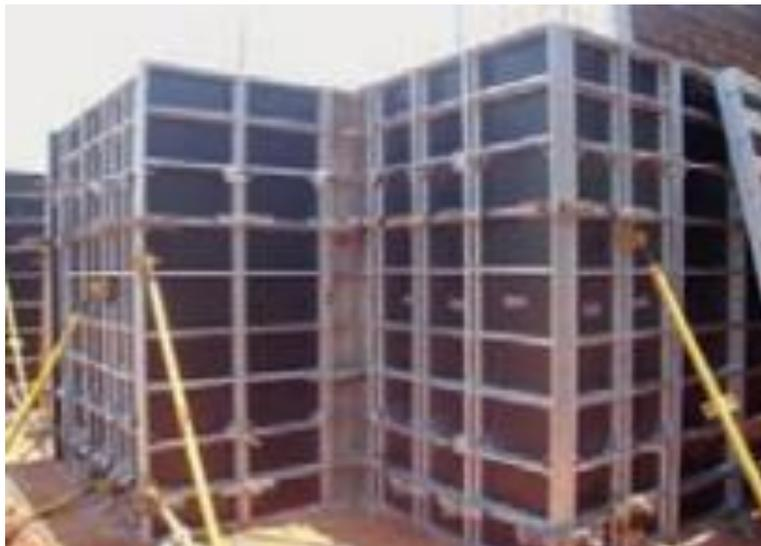
Figura 39 - Exemplo de fôrma composta por quadros metálicos e chapas de madeira compensada utilizada para concretagem de paredes de concreto.
