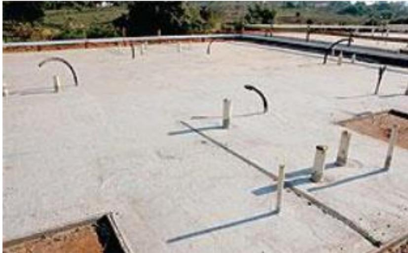
Figura 36 - Fundação em laje de apoio, radier, com as tubulações embutidas.
