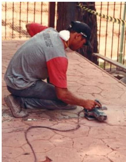
Figura 26 - Corte no piso para execução das juntas de retração.
