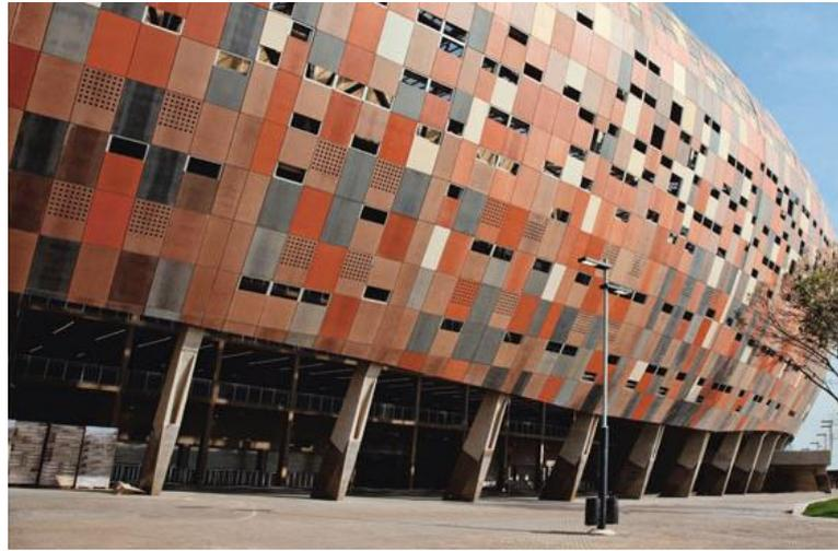
Figura 3 - Fachada do Soccer City Stadium, Johannesburgo, projetada em concreto colorido e fibras de vidro.
