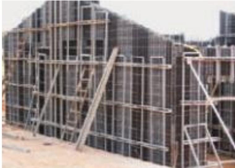
Figura 40 - Exemplo de fôrma plástica utilizada para concretagem de paredes de concreto.
