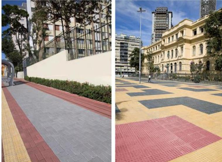
Figura 6 - Blocos intertravados de concreto colorido formando mosaicos.
