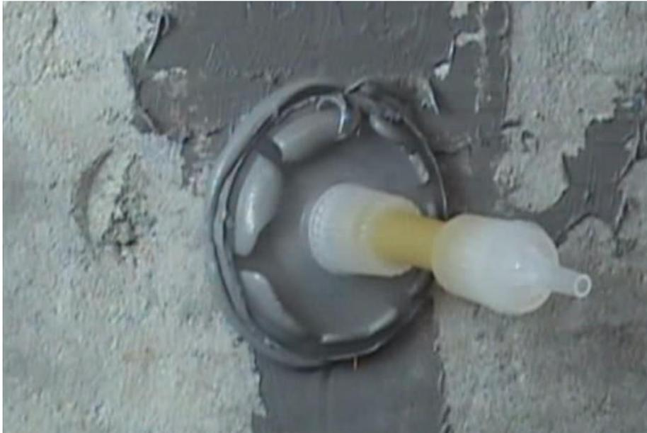
Figura 19: Equipamento para injeção de resinas epoxídicas (FONTE: site da ADHESIVES TECHNOLOGY)
