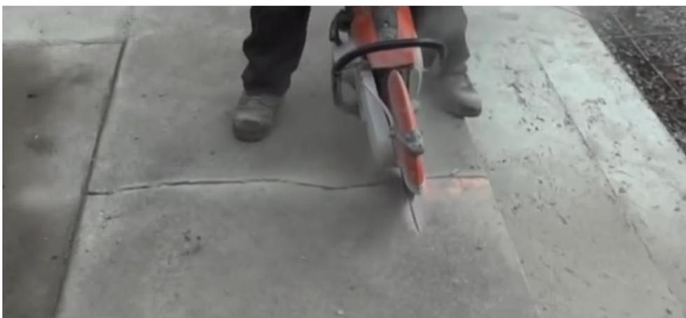
Figura 21: Corte transversal a fissura onde será posicionado o grampo (FONTE: site da CONCRETE STAPLE)
