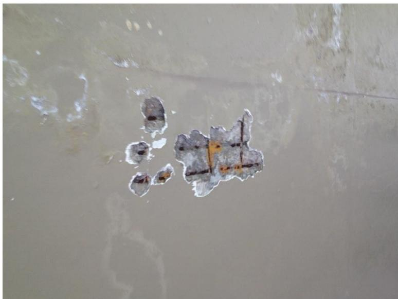
Figura 10: Armadura exposta e enferrujada em laje na entrada do Centro de Tecnologia da UFRJ (FONTE: O autor)
