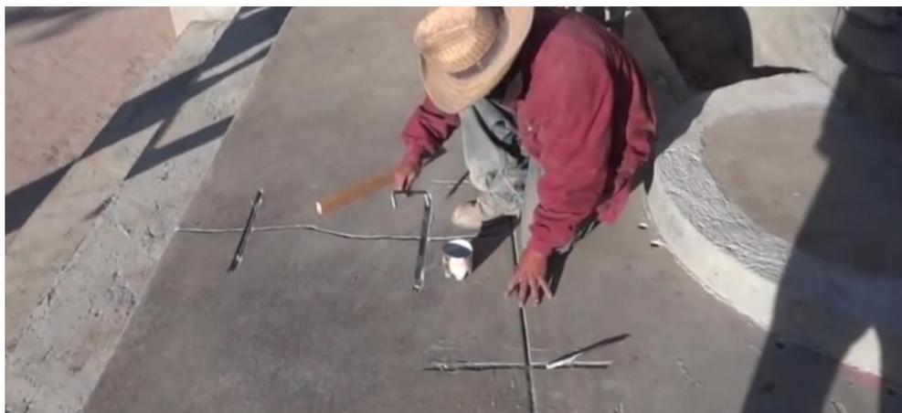
Figura 23: Aplicação de resina epóxi e colocação do grampo (FONTE: CONCRETE STAPLE)
