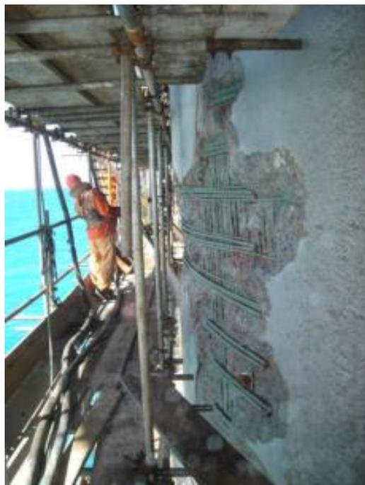
Figura 18: Concreto projetado na plataforma de petróleo no Estado do Rio Grande do Norte (FONTE: Marcos ANJOS – et. al, 2007)
