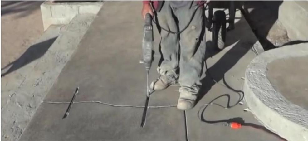
Figura 22: Furadeira executando os furos onde serão cravados os grampos (FONTE: CONCRETE STAPLE)
