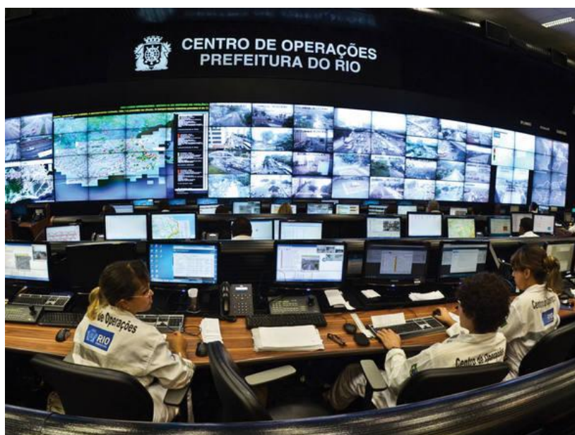
Figura 30: Sala de Controle do COR (ROTHMAN, 2014)
