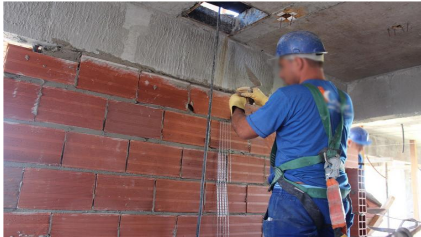
Figura 10 – Alvenaria de vedação em bloco cerâmico
