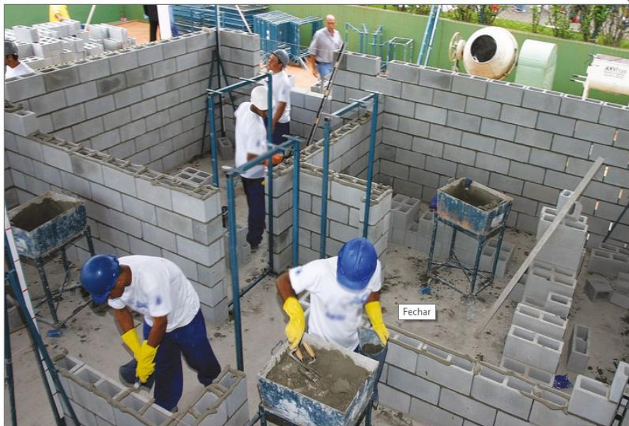
Figura 11. Alvenaria estrutural com blocos de concreto Fonte: portalvirtuhab.paginas.ufsc.br/alvenaria-estrutural-com-blocos-de-concreto
