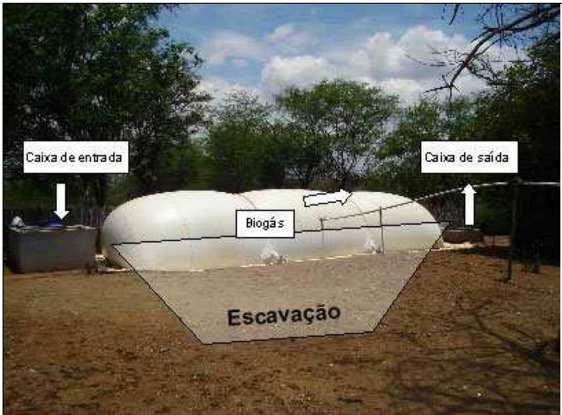
Foto 1 - Biodigestor canadense utilizado na Estação Experimental de Caraíbas - EBDA (Jaguarari - BA) (Fonte: Manual de Treinamento em Biodigestão (2008))
