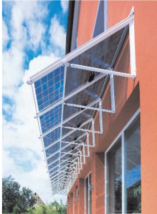
Figura 60: Parasoles fotovoltaicos en el edificio centro de diseño en kuppenheim, Alemania. Fuente: Guía integración fotovoltaica
