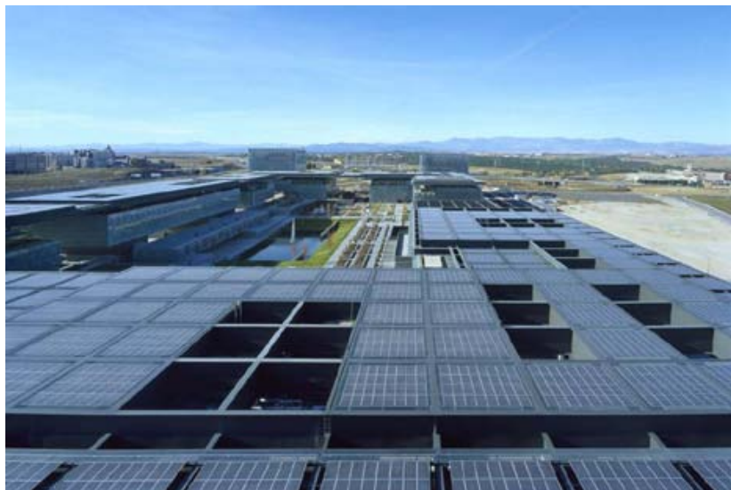
Foto 35: Cubierta fotovoltaica Sede de Telefónica en Madrid. Fuente: www.construible.es
