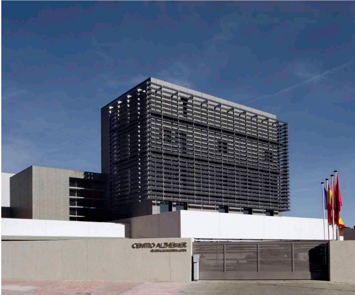
Figura 93: Fachada fotovoltaica de la Fundación Reina Sofía. Fuente: Guía Integración Fotovoltaica comunidad de Madrid
