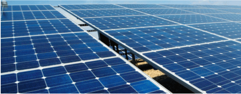
Figura 46: paneles con módulos de células planas cristalinas. Fuente: www.publispain.com
