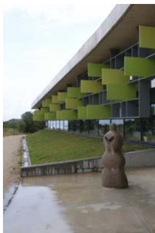
Figura 31: Biblioteca Can Llauredor de Teia. Godia&Barrio. Fuente: Revista INNOTECH Vol. 1, Eficiencia Energética
