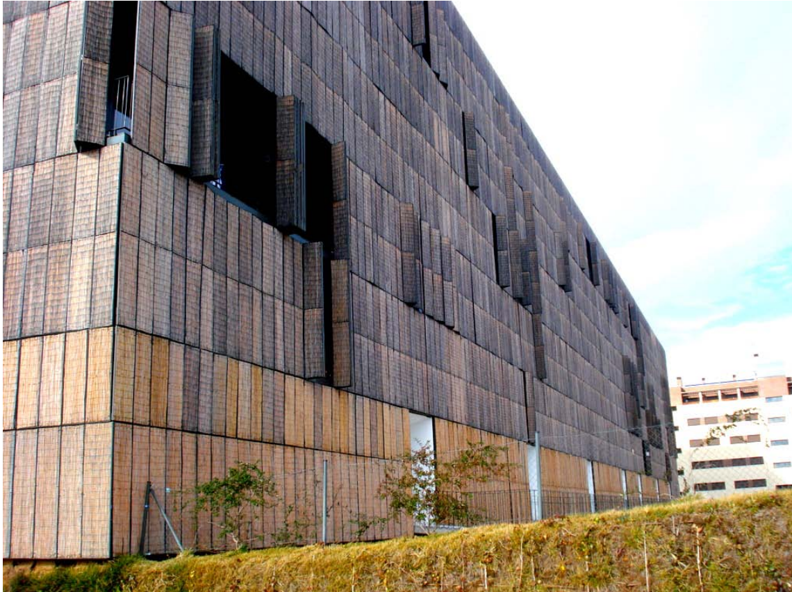
Figura 81: Fachada de bambú. Fuente: Foto Elaine Garrido
