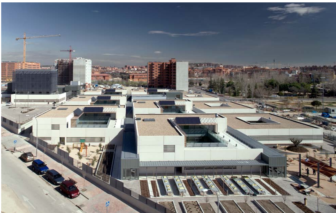
Figura 94: Complejo PAU de Vallecas. Fuente: Guía Integración Fotovoltaica comunidad de Madrid
