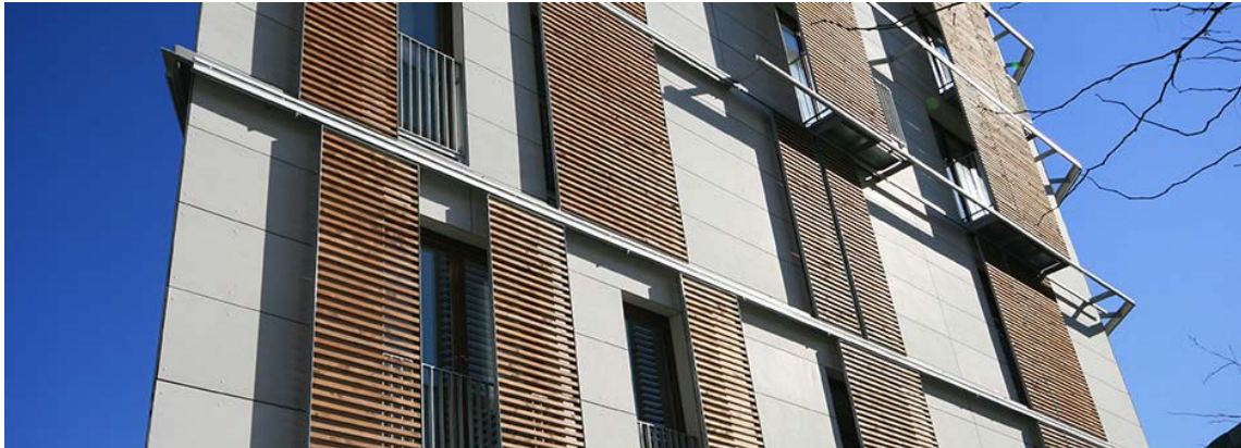
Figura 40: Ventanas mallorquinas o contraventanas de lamas. Fuente: http://www.tamiluz.info
