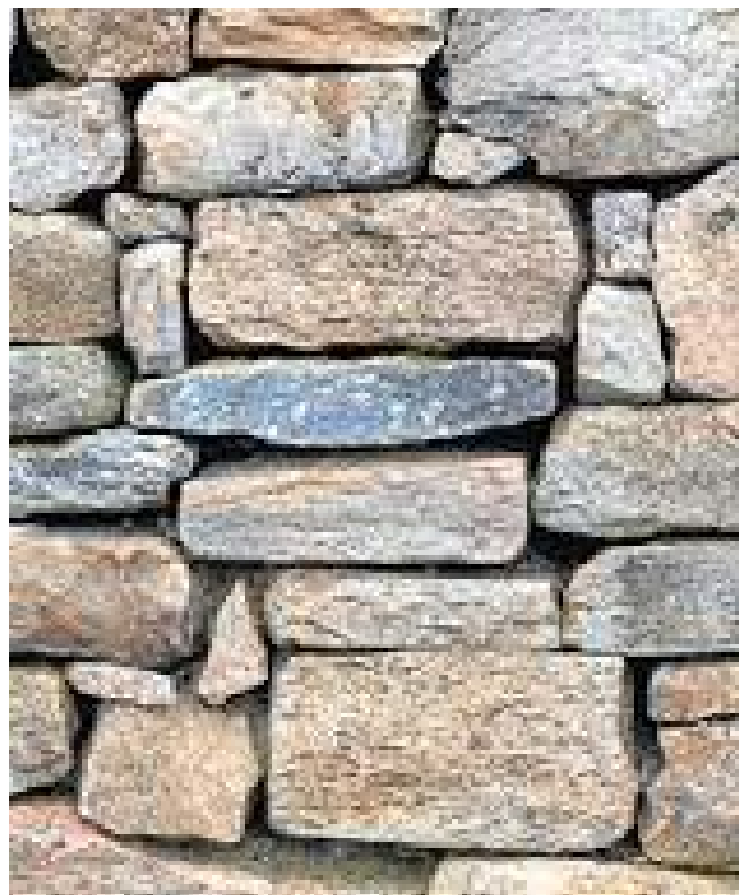
Figura 15: Muro de mampostería. Fuente: www.bibliocad.com
