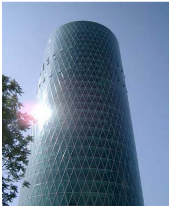
Figura 43: Torre en Frankfurt contruida en 2003 con vidrios de protección solar. Fuente: www.reflectiv.com
