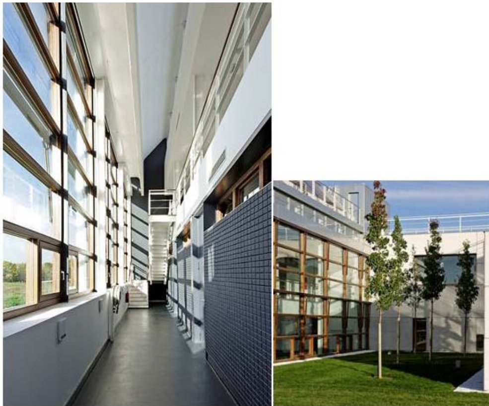
Figura 26: Sede CENER en Pamplona (España). Fuente: Guía integración fotovoltaica de la Comunidad de Madrid.
