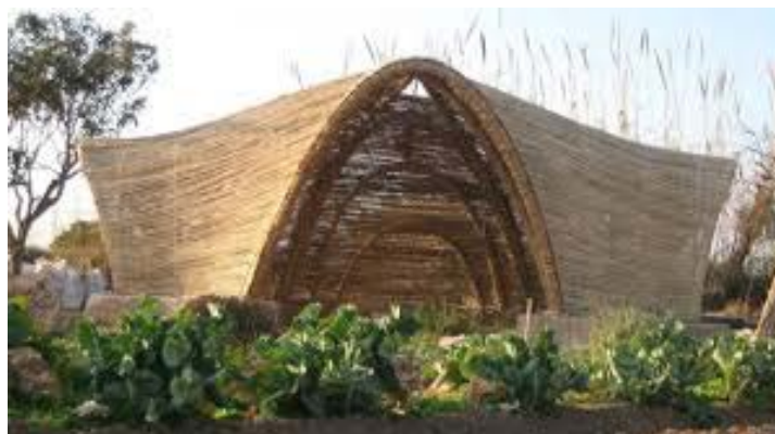
Figura 12: casa techada con paja en costa Rica. Fuente: www.arquitecturacostarica.com
