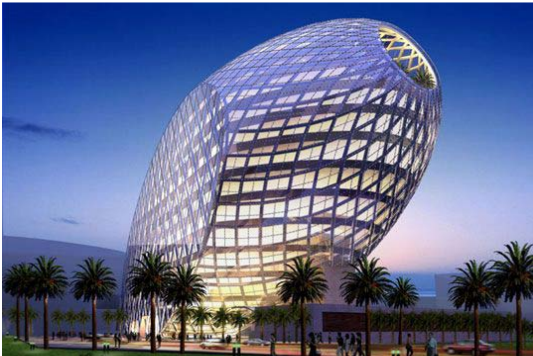
Figura 6: Edificio en Mumbai, India, obra de James Law. Fuente: http://www.arquitexs.com/2010/11
