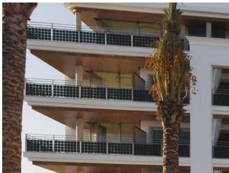
Figura 61: Barandillas del Hotel Aguas de Ibiza formadas por módulos FV vidrio/vidrio de color verde. Fuente: Guía integración fotovoltaica
