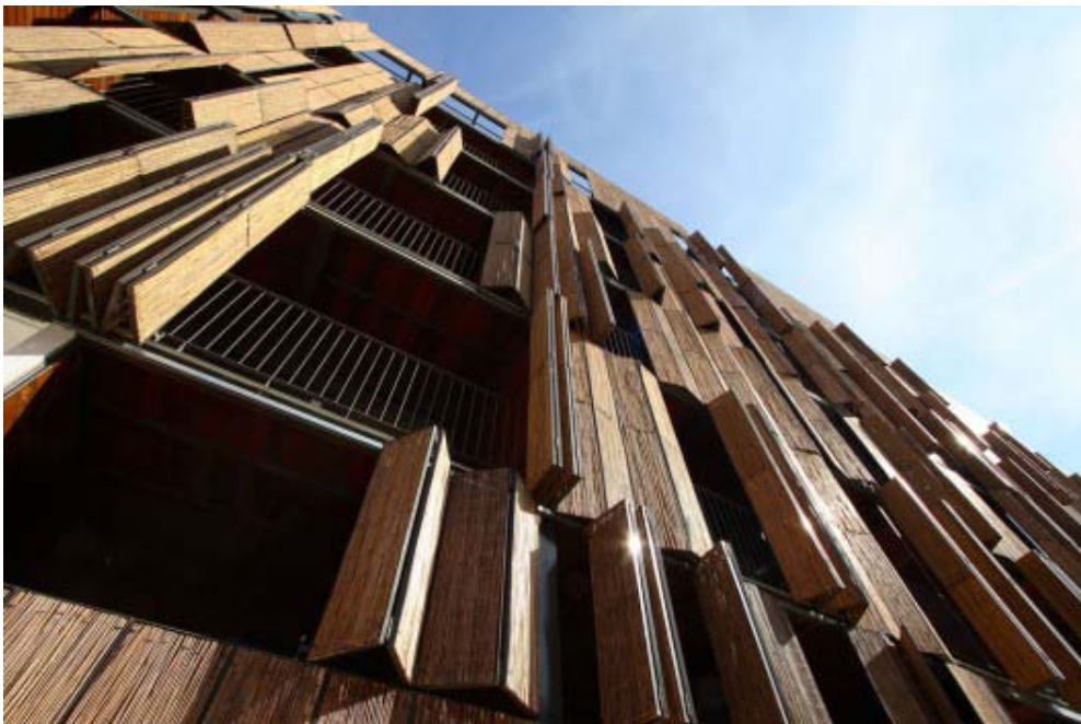
Figura 84: Protecciones solares de bambú. Fuente: Revista INNOTECH Vol. 1, Eficiencia Energética
