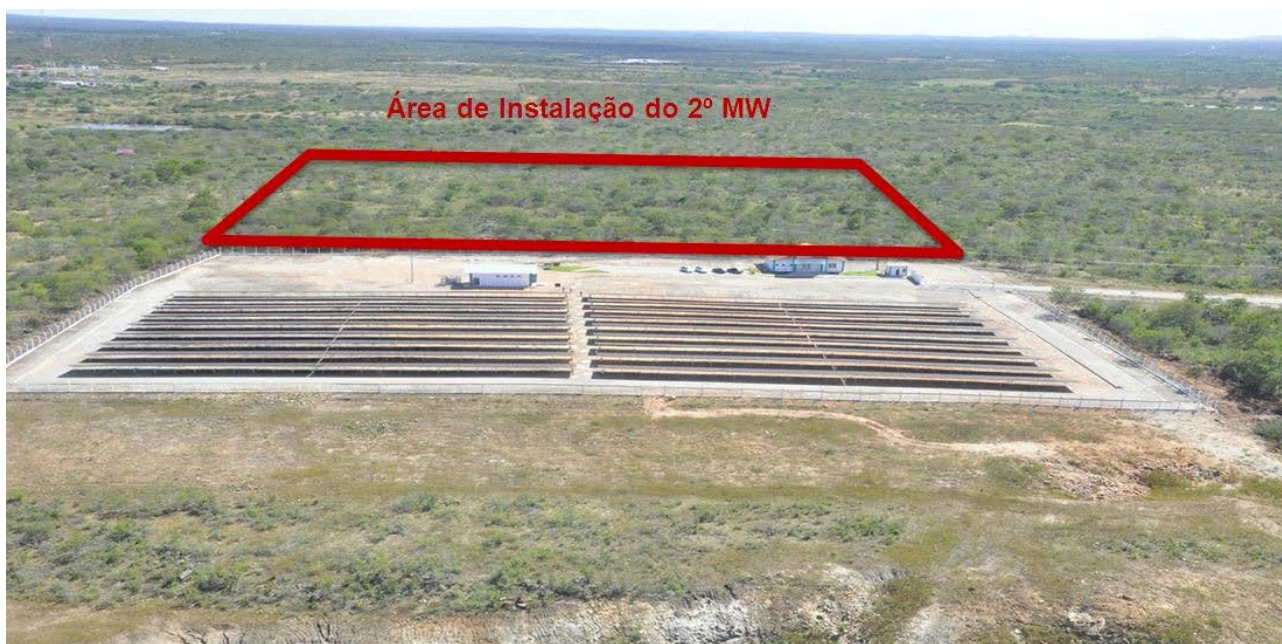
Figura 4.1 - Localização da área aproximada onde será instalado o 2º MW da Usina Solar de Tauá
