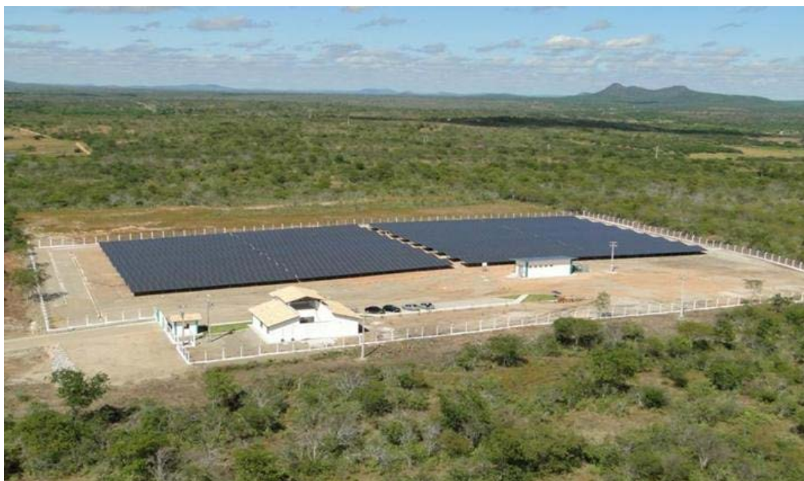
Figura 3.1 - Vista geral da Usina Solar de Tauá (1 MW)
