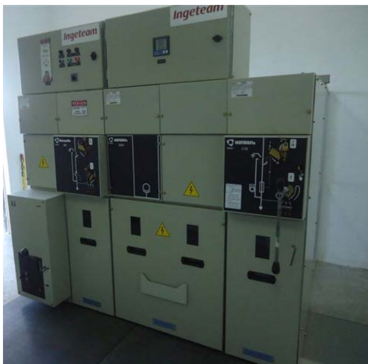
Figura 3.21 - Cubículo de Média Tensão da fabricante EFACEC, montado pela INGETEAM
