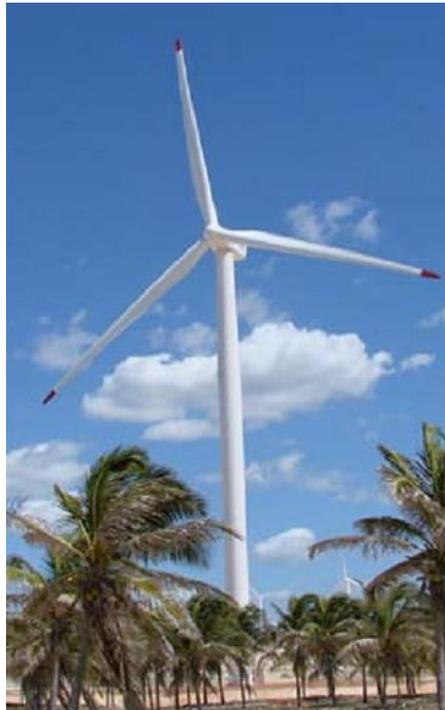
Figura 3.2 – Turbina de eixo horizontal [8]
