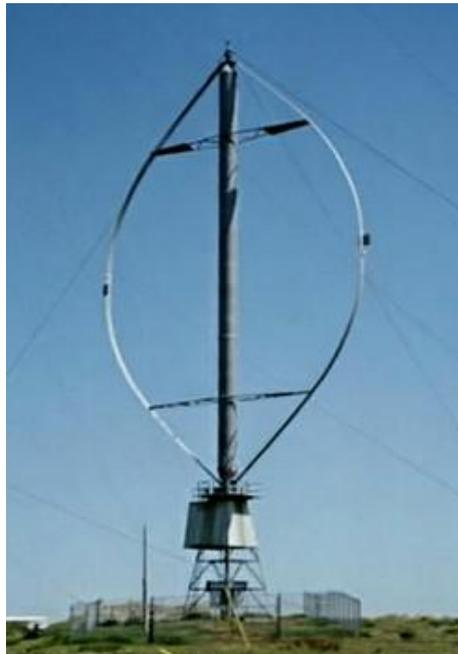
Figura 3.4 – Turbina Darrieus de pás curvas [10]
