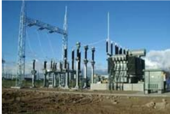
Figura 7 - Subestação Elevadora.[6]
