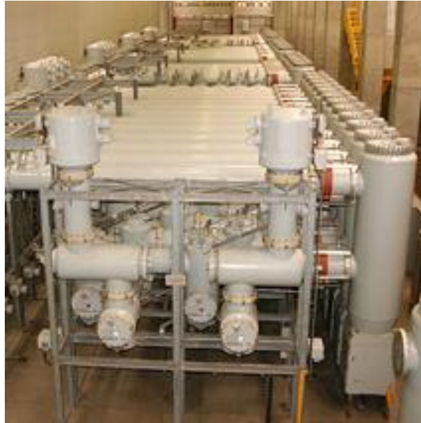
Figura 12 - Subestação Blindada. [11]
