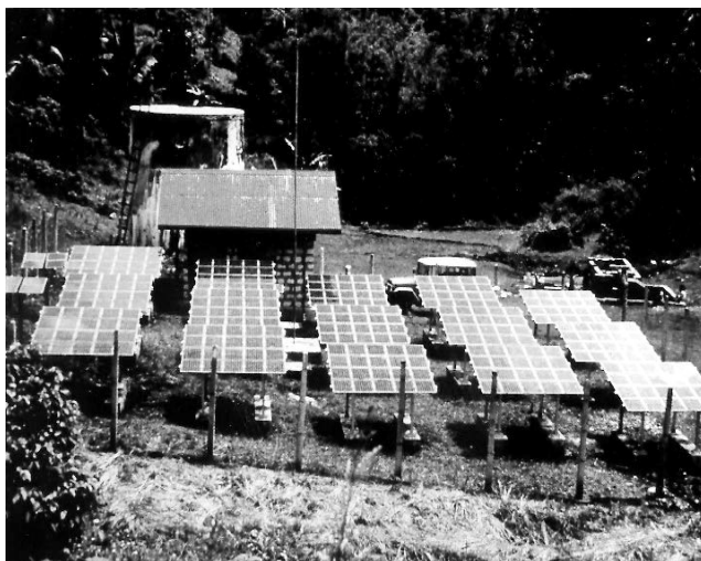
Figura 26: Sistema fotovoltaico em Sumba, Indonésia, capaz de fornecer água potável para 4000 pessoas.
