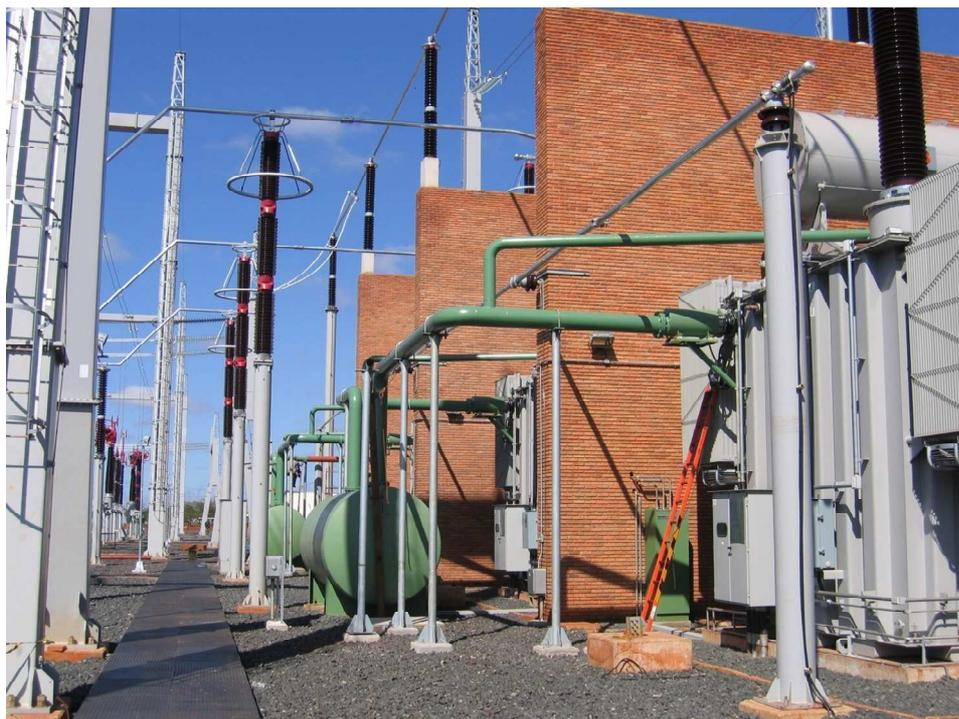
Figura A3 – Tubulações coletoras de óleo e de evacuação de gases
