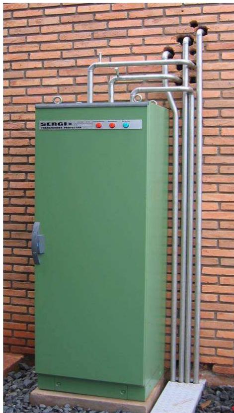
Figura A6 – Armário contendo cilindros de nitrogênio.
