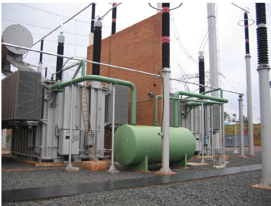
Figura A2 – Tanque de separação de óleo e gases
