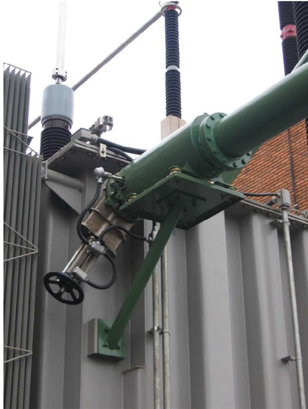
Figura A5 – Conjunto de despressurização do tanque principal do transformador
