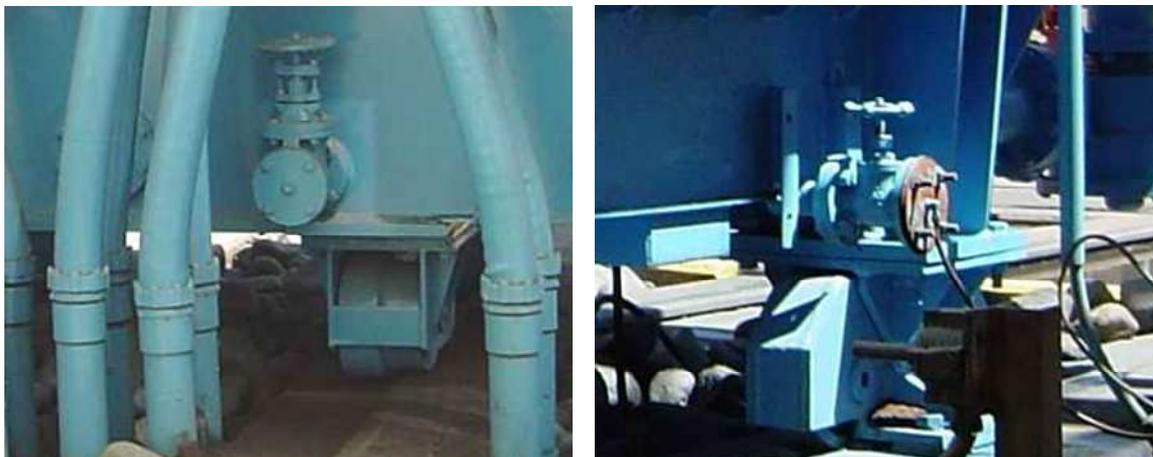
Figura 6.19 – Válvulas para coleta de amostra e drenagem de óleo
