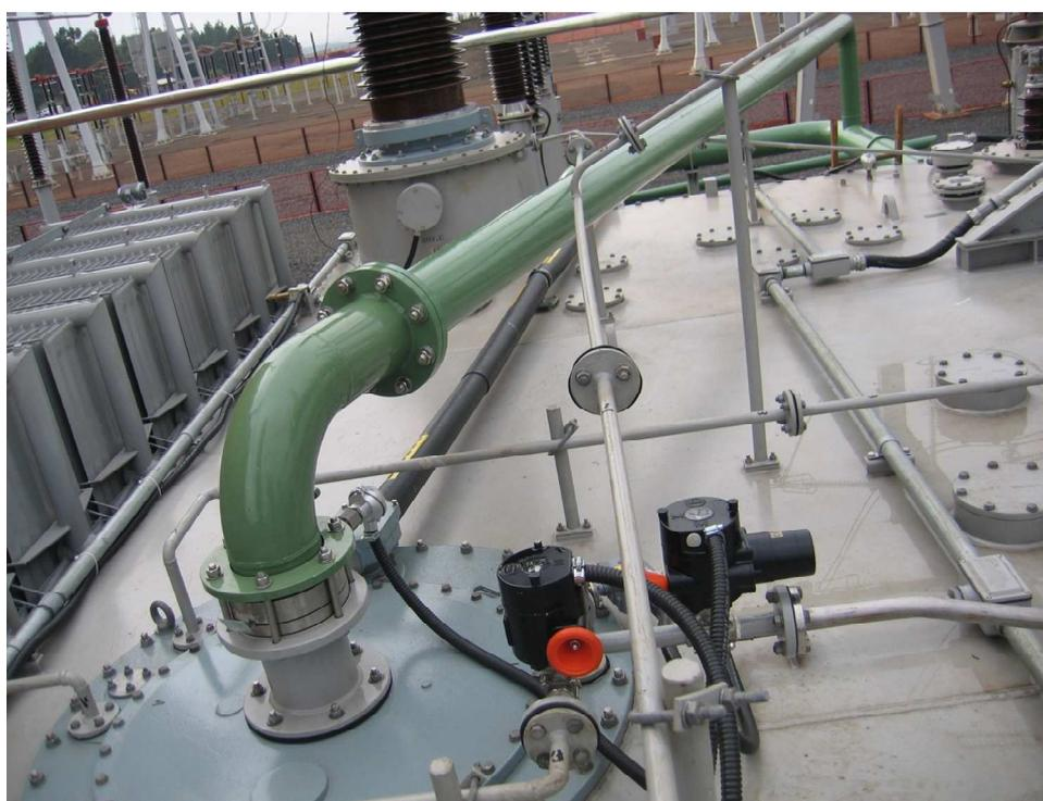
Figura A4 – Conjunto de despressurização e tubulações instalados em um comutador sob carga.
