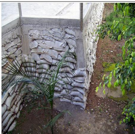
Figura 122: Aterro executado na calha do rio.
