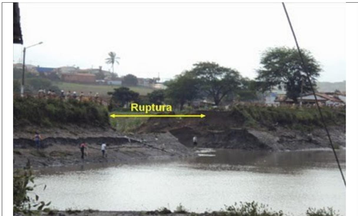
Figura 13: Fotografia que apresenta a área de ruptura da barragem. Disponível em <<http://zonaderisco.blogspot.com>>.
