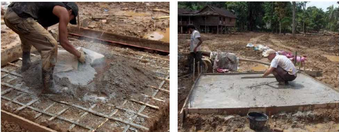
Figura 20 - Armação de bambu em uma laje. The Constructor (2017)
