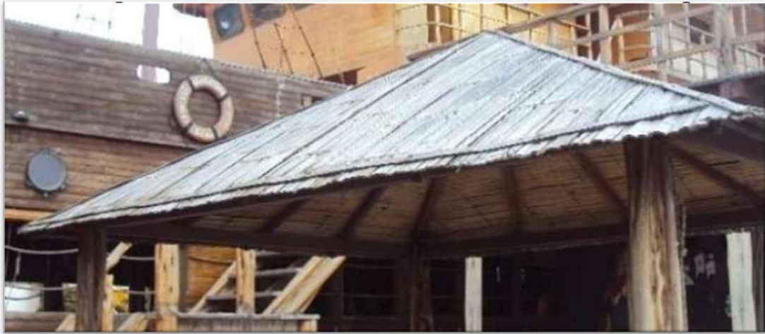
Figura 24 - Aparência da cobertura de bambu após excessiva exposição ao sol. Benavides (2012)
