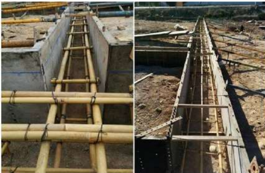
Figura 21 - Substituição de aço por bambu em estruturas de concreto armado. The Constructor (2017)
