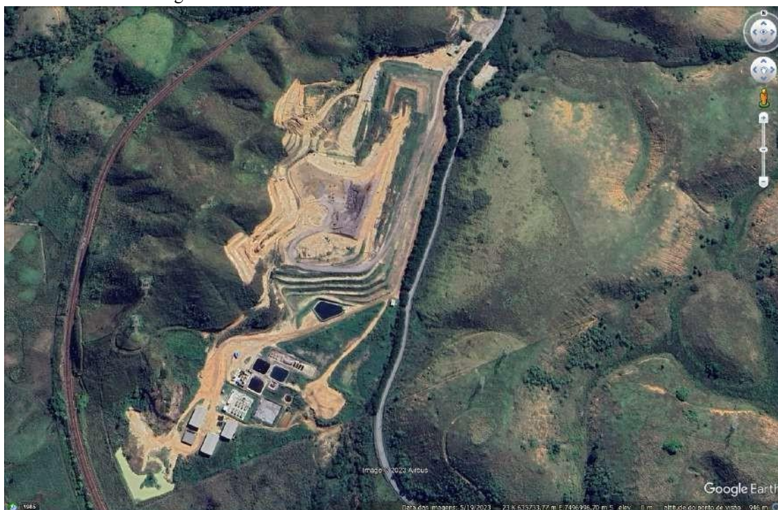
Figura 14. Vista aérea do aterro sanitário CDTR Paracambi.
