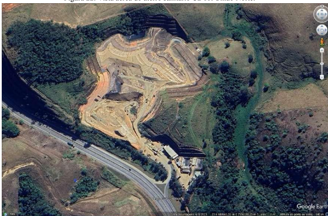
Figura 22. Vista aérea do aterro sanitário CDTR União Norte.
