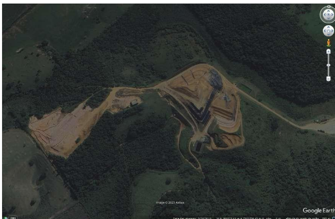
Figura 10. Vista aérea do aterro sanitário Essencis.
