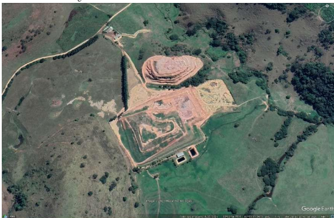
Figura 16. Vista aérea do aterro sanitário MTR Madalena.
