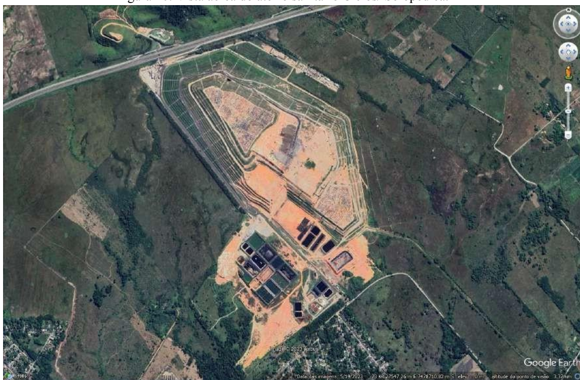
Figura 20. Vista aérea do aterro sanitário Ciclos/ Seropédica.
