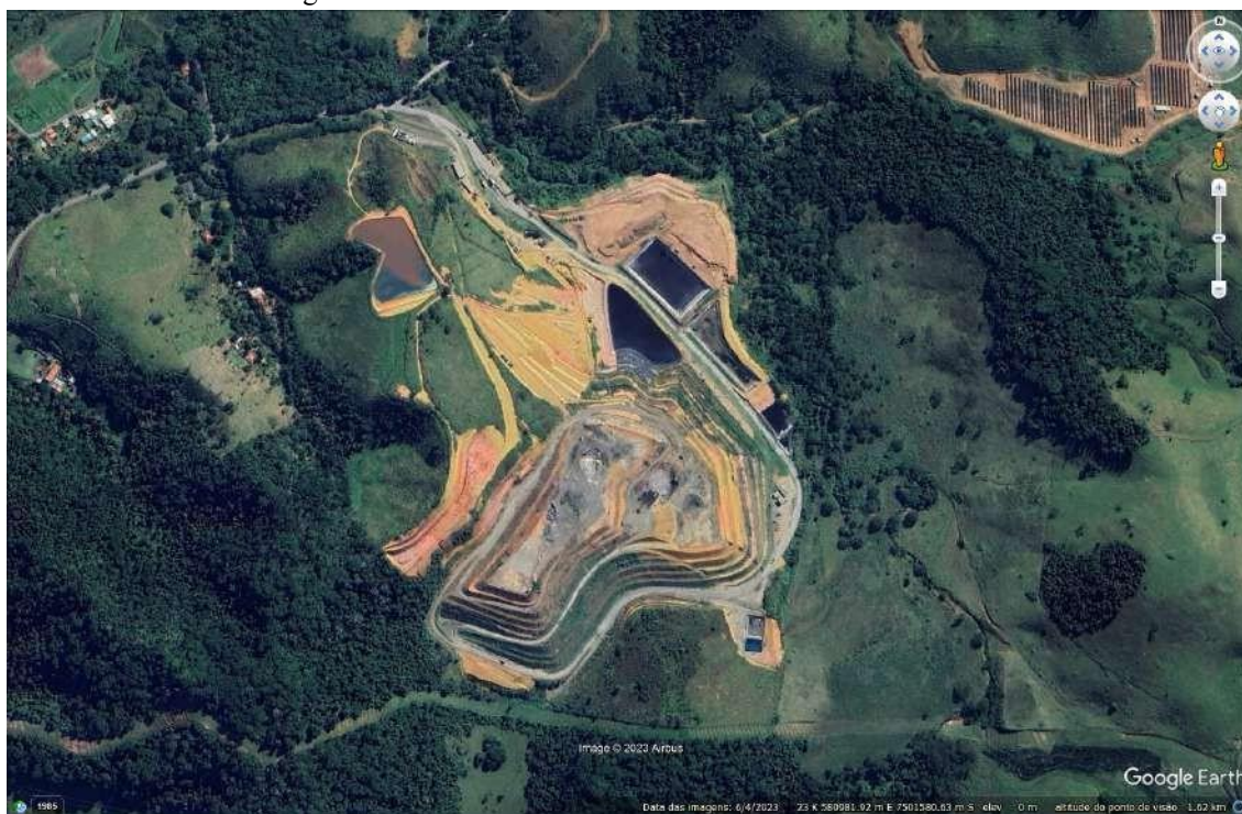
Figura 5. Vista aérea do aterro sanitário CTR Barra Mansa.
