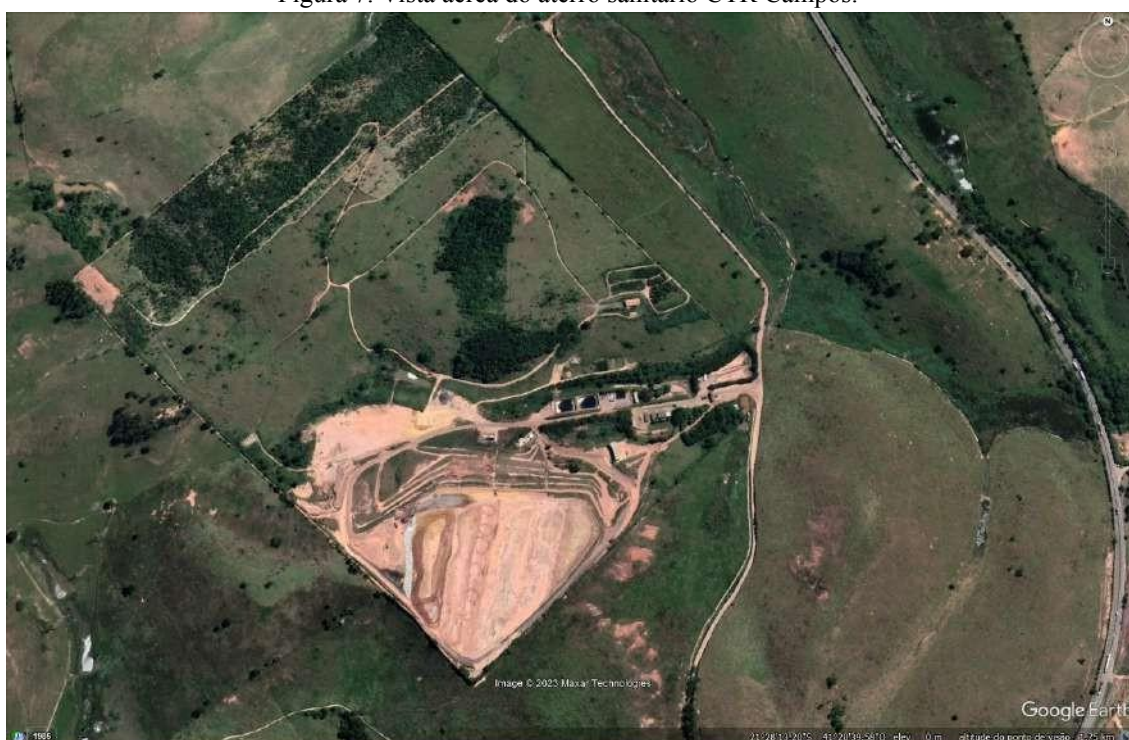
Figura 7. Vista aérea do aterro sanitário CTR Campos.
