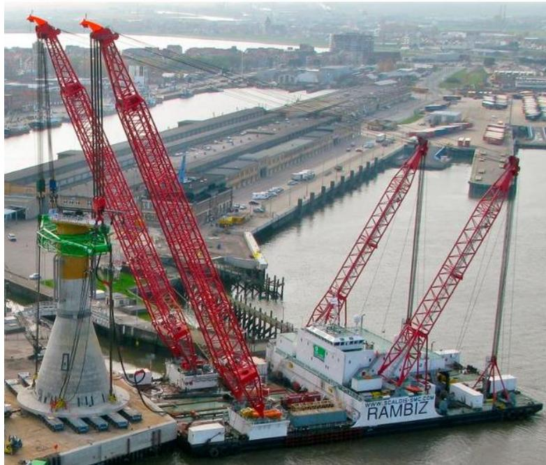
Figura 3-7 - Içamento de fundação de base de gravidade (ALONSO, 2013)
