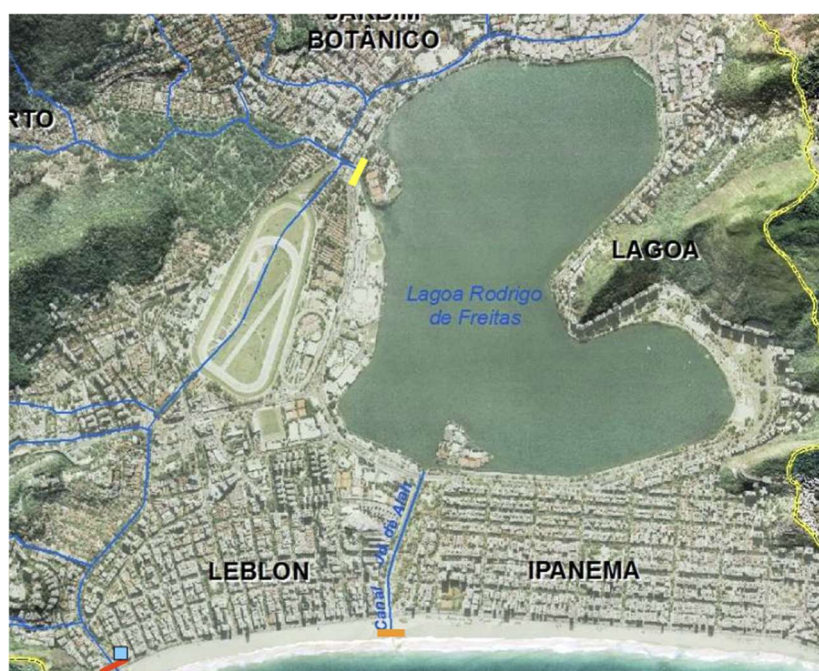
Figura 38 – Recorte da Bacia Hidrográfica da Lagoa Rodrigo de Freitas com a localização das comportas e elevatória operadas pela Rio-Águas.
