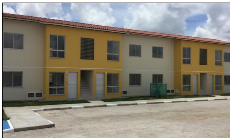
Figura 24 – Vista da fachada de uma das edificações do Residencial Reserva do Parque, em 2015, antes da entrega efetiva das chaves aos proprietários
