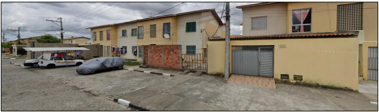
Figura 30 – Construções em áreas comuns no Residencial Reserva do Parque, em 2022
