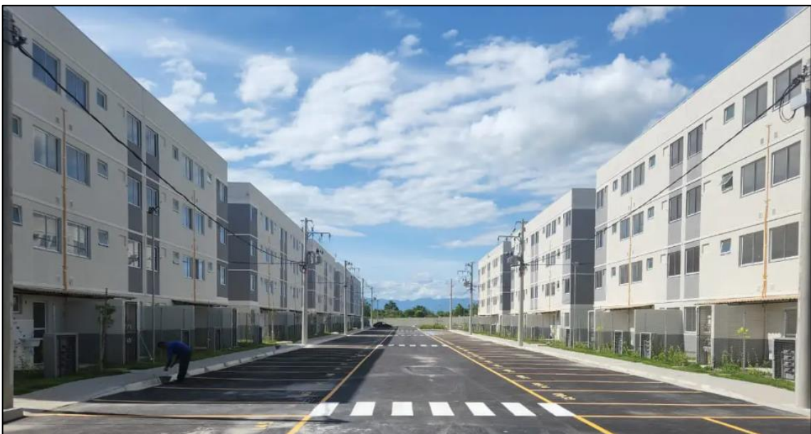
Figura 34 – Residencial Viver Mais já construído, em fase de finalização. Fonte: https://www.rdrengenharia.com/empreendimento/viver-mais-itaborai/#contatoForm
