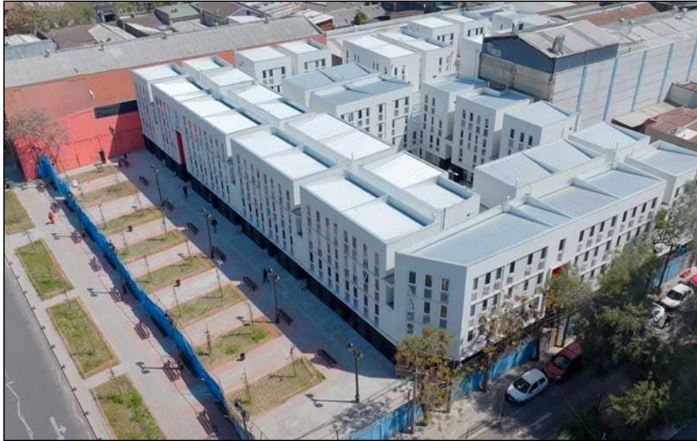
Figura 55 – Vista superior da região frontal do empreendimento Pátios de Copiapó
