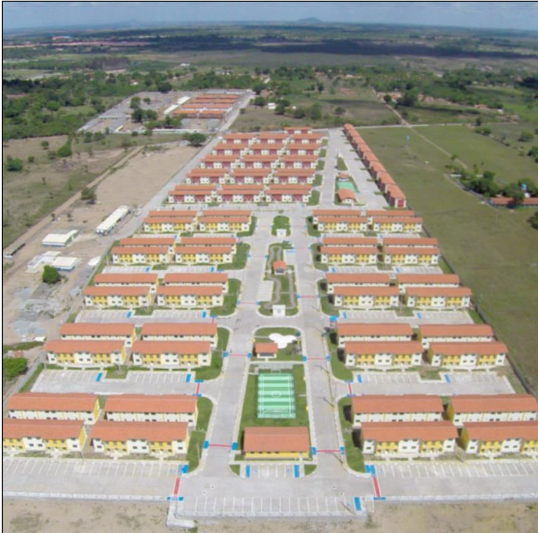
Figura 25 – Vista superior do Residencial Reserva do Parque Fonte: www.cepreng.com.br
