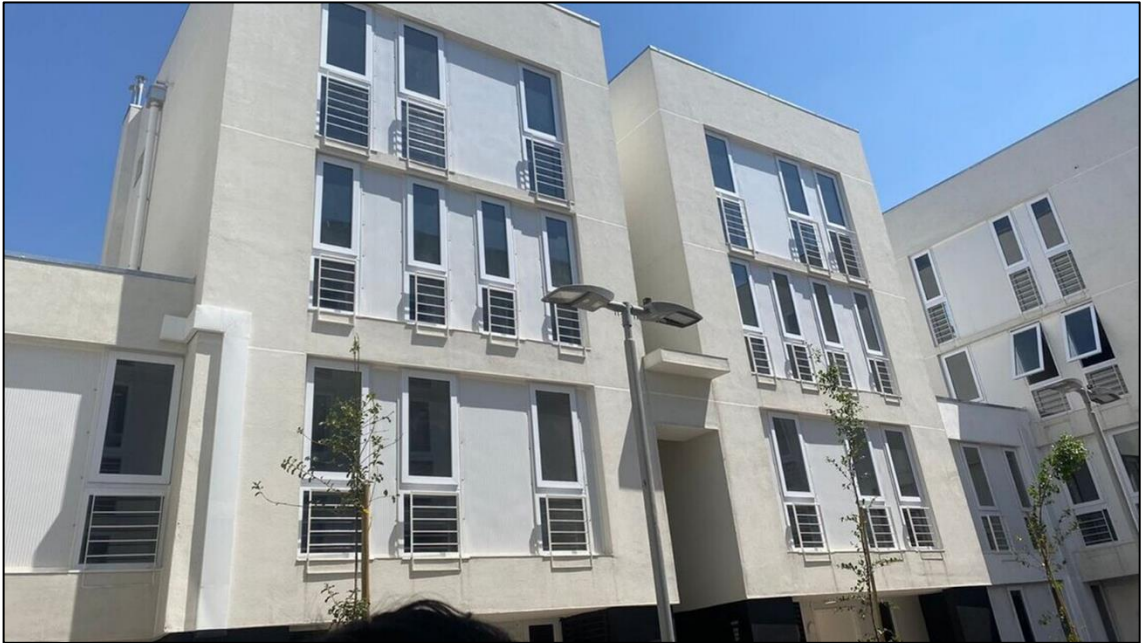
Figura 53 – Fachada interna do empreendimento Pátios de Copiapó Fonte: incorporadora DEMO
