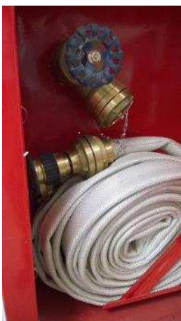
Figura 49 Abrigo, mangueiras e esguicho Fonte: Elaboração própria, 2018
