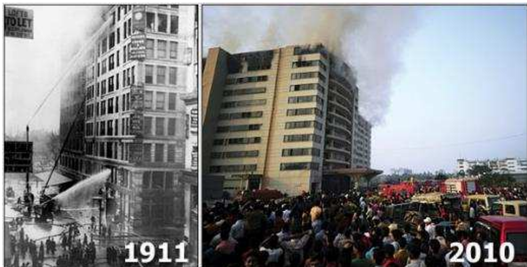
Figura 1- O incêndio Triangle Waist Co. em Nova York (à esquerda) e a fábrica Ha-Meem em Bangladesh
