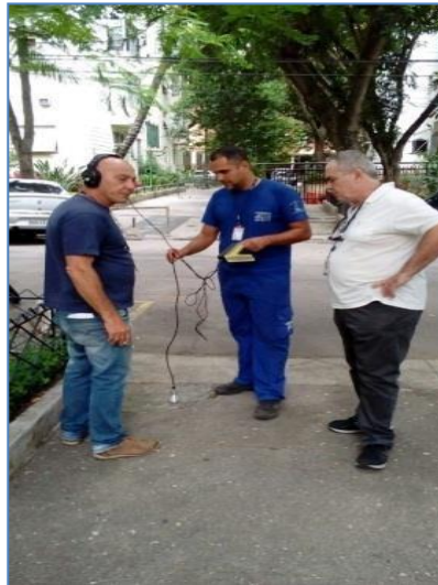
Figura 32 – Uso de haste de escuta na busca de vazamentos não visíveis
