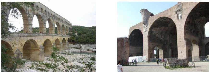
Figura 6: Aqueduto Pont du Gard e ruínas da Basílica de Constantino
