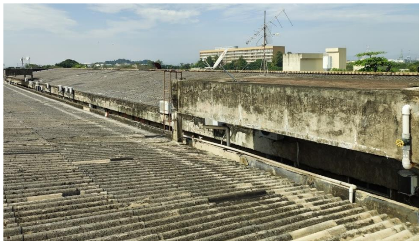
Figura 19: Vista aérea da cobertura do Bloco H
