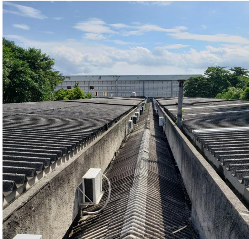
Figura 21: Cobertura Bloco D
