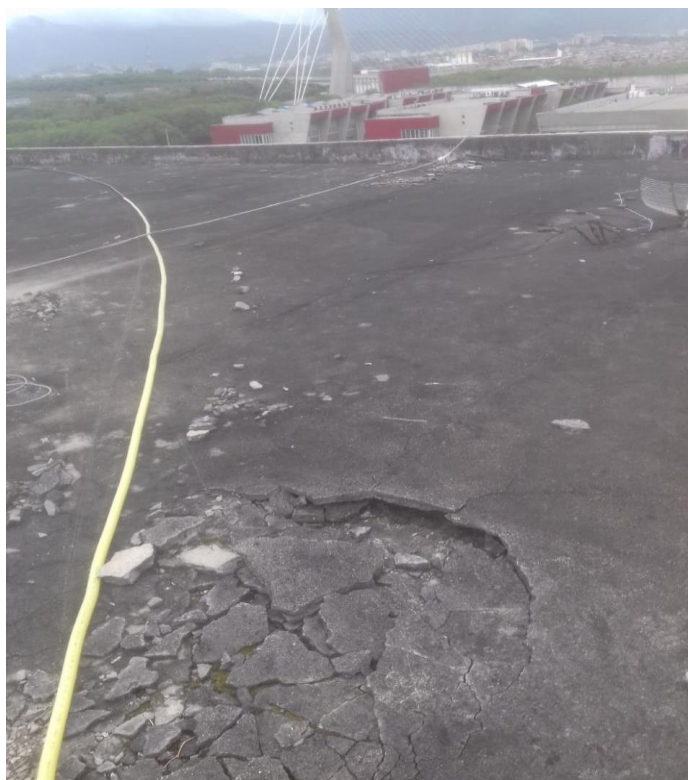
Figura 20: Cobertura Bloco I - Nave central
