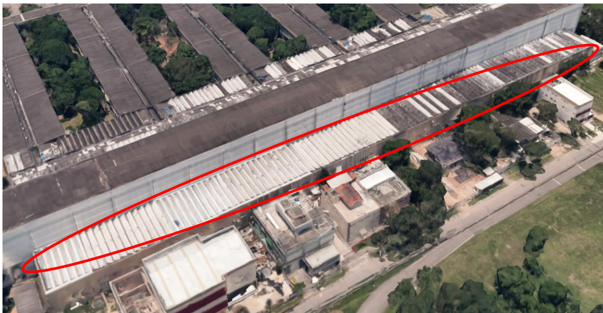
Figura 22: Cobertura Bloco I- Shed
